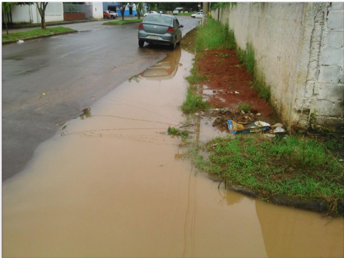
Figura 20: Empoçamento de água pluvial
