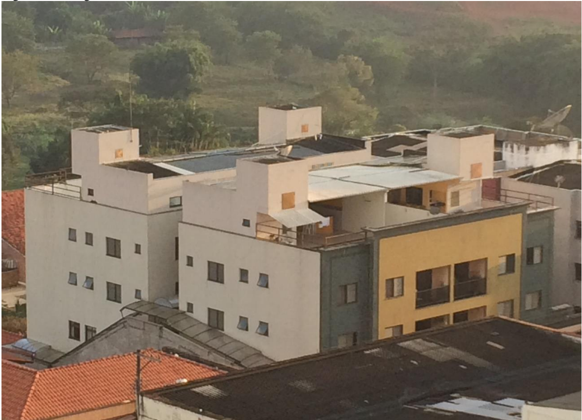
Figura 03 - Imagem aérea do telhado do Edifício Alfredo Fressato
