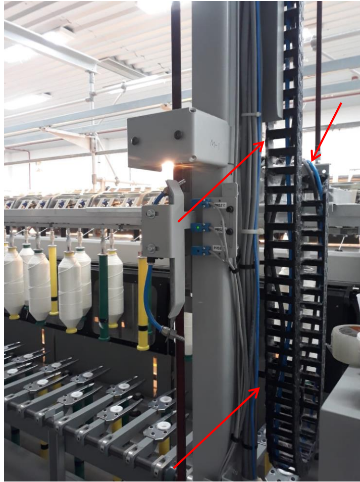
Figura 38: Passamento da mangueira pneumática pela esteira porta cabos.
