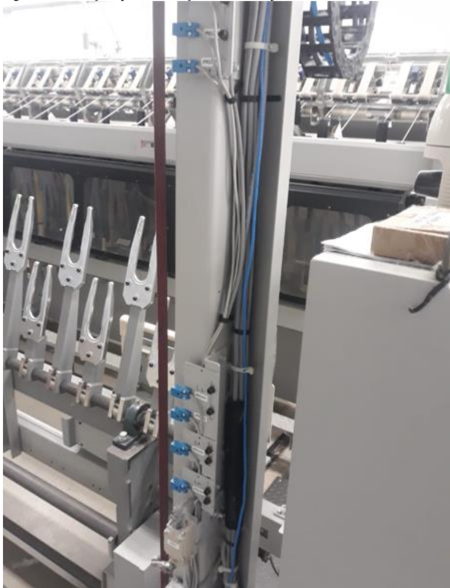
Figura 46: Condição após a instalação dos bicos injetores.
