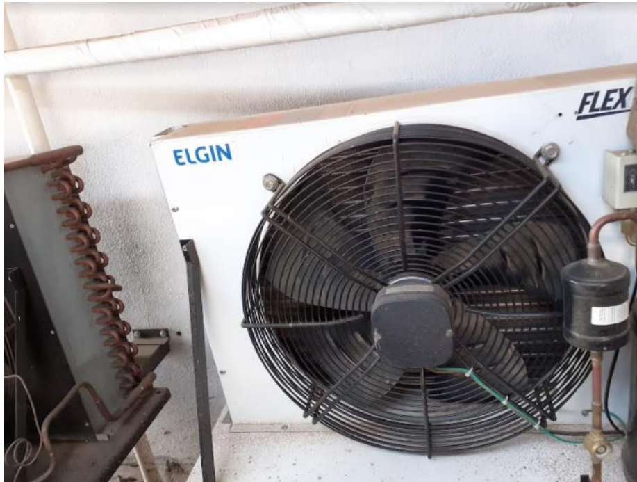
Figura 7: Unidade Condensadora Hermética SLM02350TTC51A.
