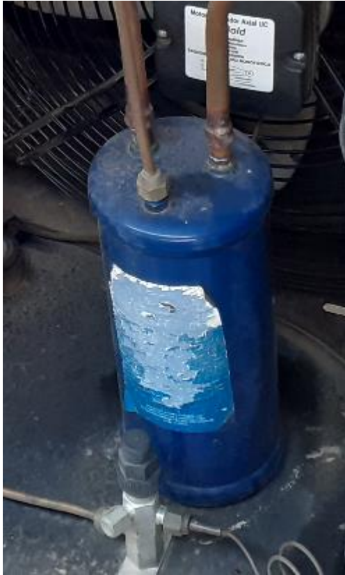
Figura 10: Separador de Líquido ELGIN.
