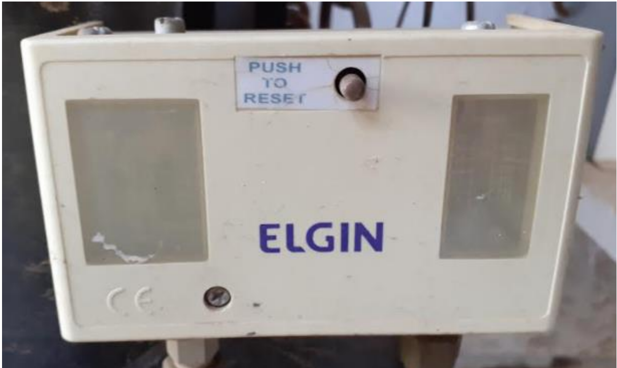
Figura 14: Pressostato.
