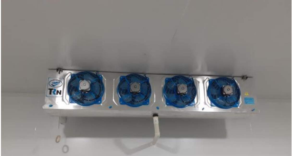
Figura 12: Evaporador Frigorífico de Ar Forçado.
