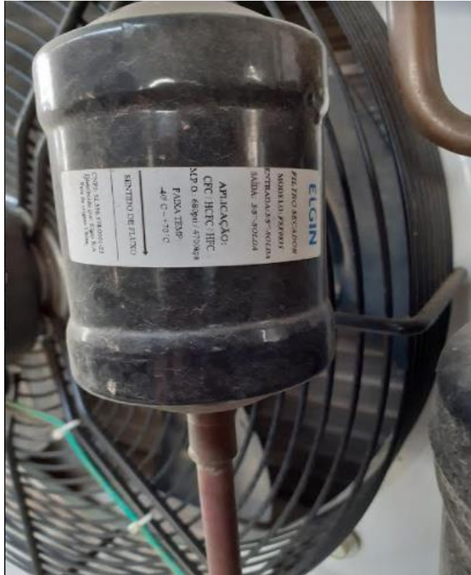
Figura 8: Filtro Secador.
