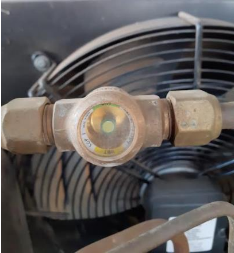
Figura 11: Visor de Líquido.
