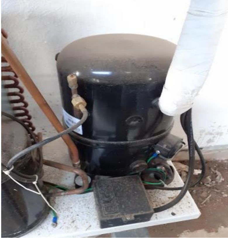
Figura 6: Compressor Hermético ELGIN ECM 42000T.
