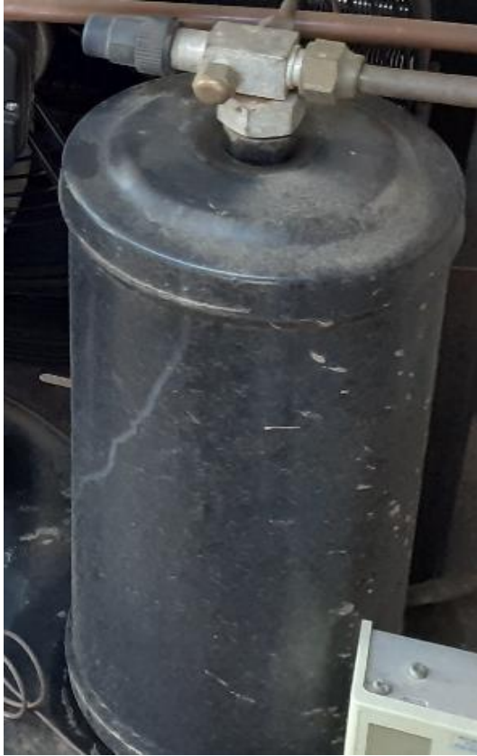
Figura 9: Reservatório de Líquido.
