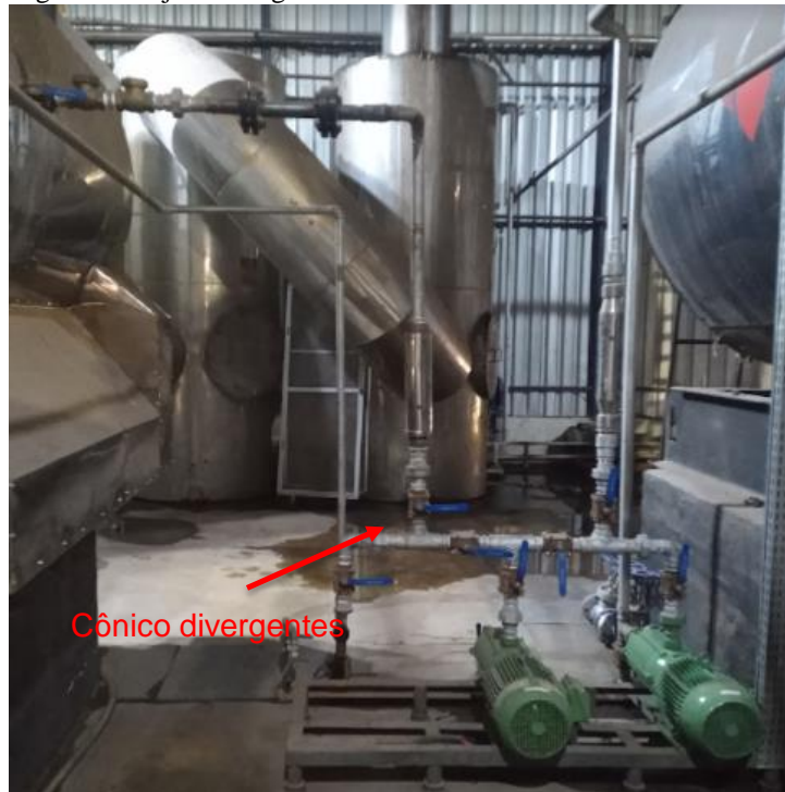
Figura 11: Injetor de água e Bombas alternativas.
