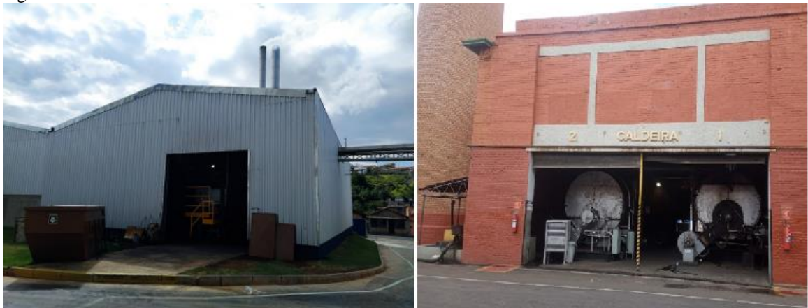
Figura 14: Casa de caldeira cavaco e óleo
