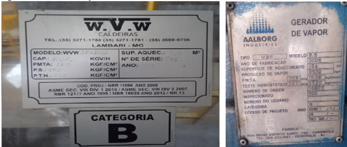
Figura 8: Placa de identificação
