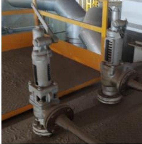
Figura 10: Válvula de segurança.
