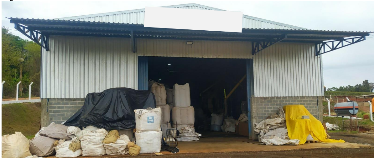
Figura 13: Vista frontal do armazém de café.
