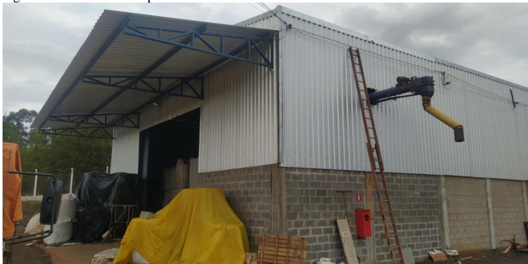
Figura 14: Vista lateral da parte de fora do armazém.
