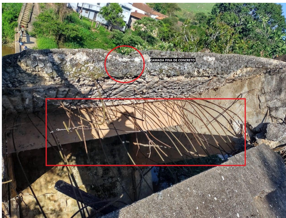
Figura 2 - Detalhamento de ferragem
