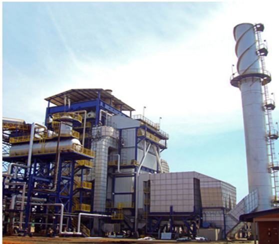
Fotografia 3: Caldeira Aquatubular para co-geração de energia
