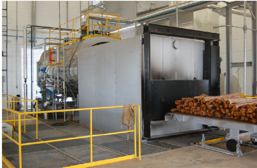
Fotografia 4: Caldeira mista (fornalha aquatubular, corpo fogotubular)
