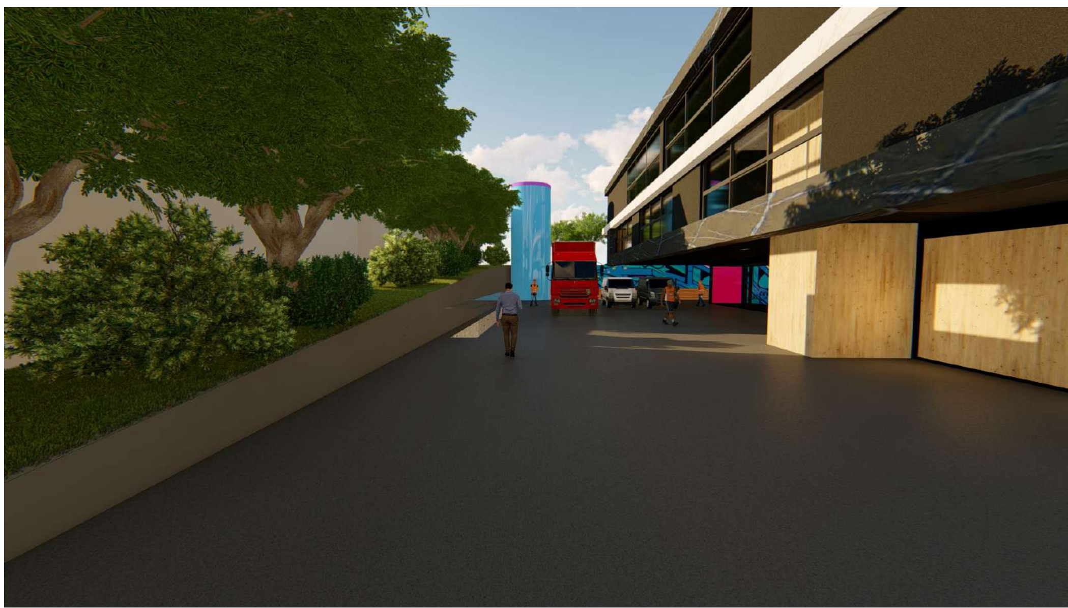
Perspectiva da doca, ao fundo temos a área de carga e descarga, a caixa d'água do edifício a esquerda e a direita temos os depósitos e elevador de carga.
