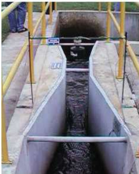
Figura 19: Geometria Calha Parshall
