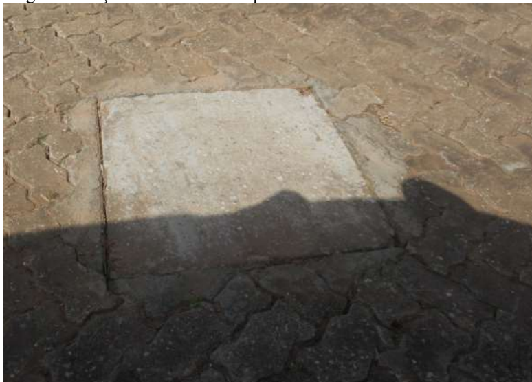
Figura 5: Poço de visita com tampa de concreto.
