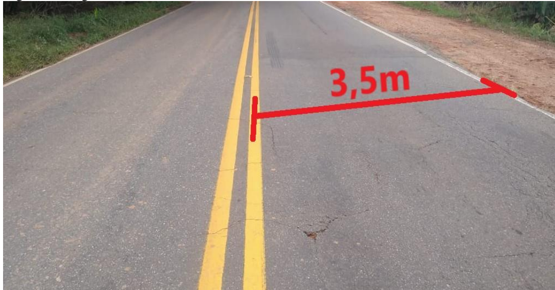
Figura 3 - Largura das faixas de rolamento
