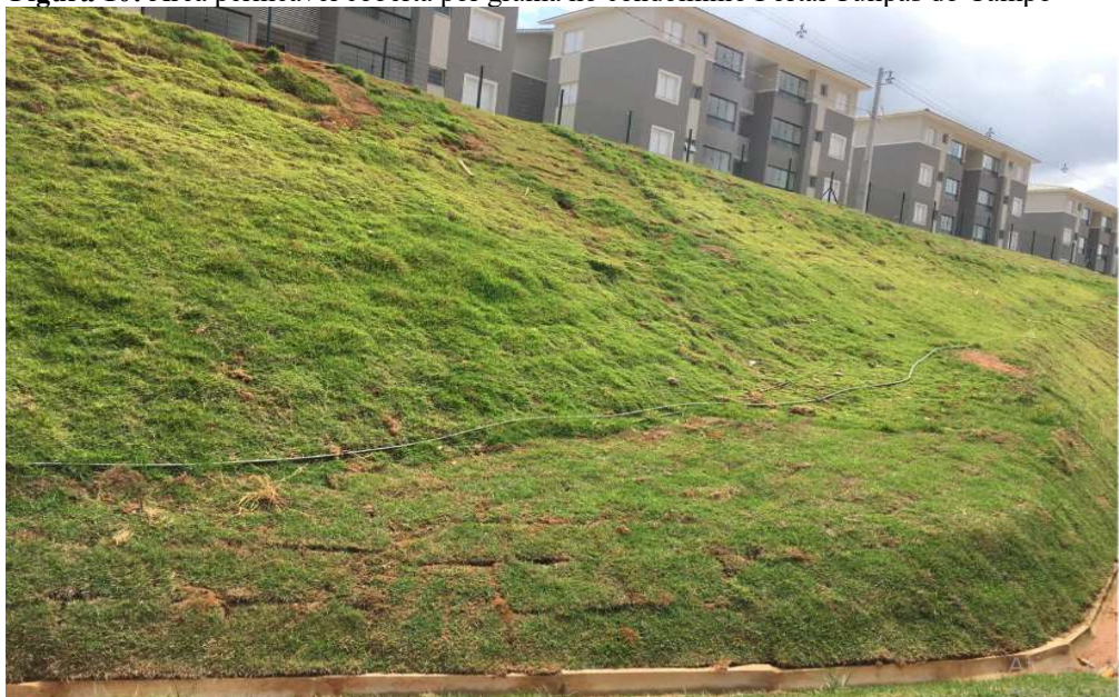
Figura 10: Área permeável coberta por grama no condomínio Portal Tulipas do Campo
