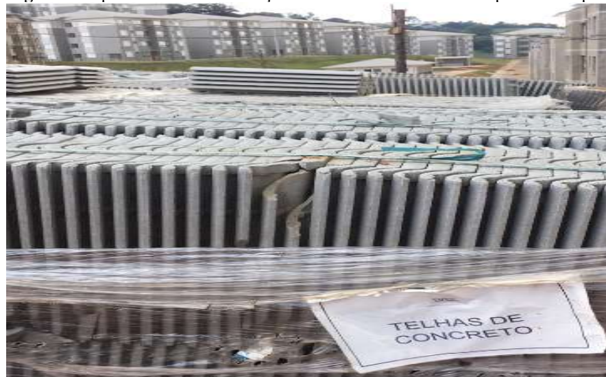
Figura 5: Tipo de telha das edificações do condomínio Portal Tulipas do Campo.
