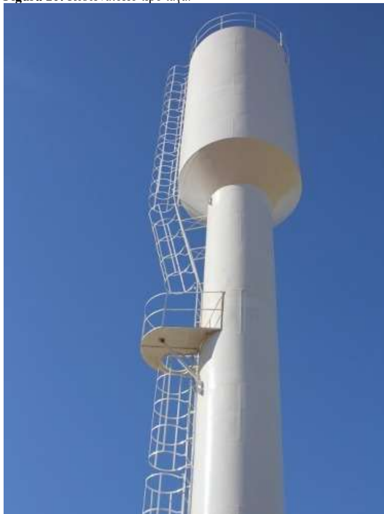
Figura 20: Reservatório tipo taça.
