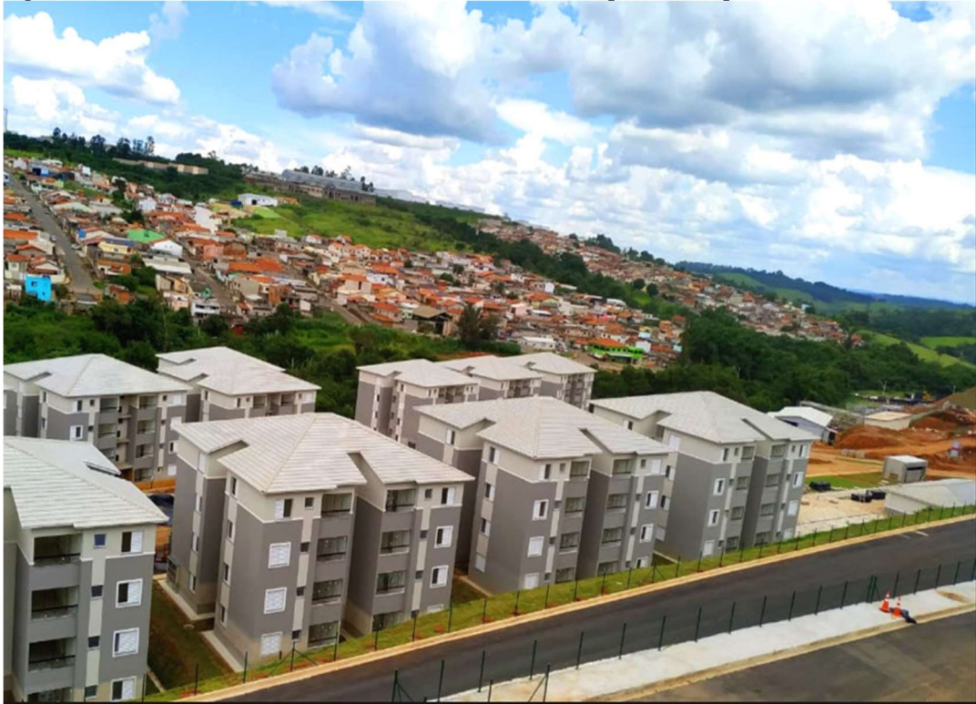
Figura 6: Telhados das edificações do Condomínio Portal Tulipas do Campo.
