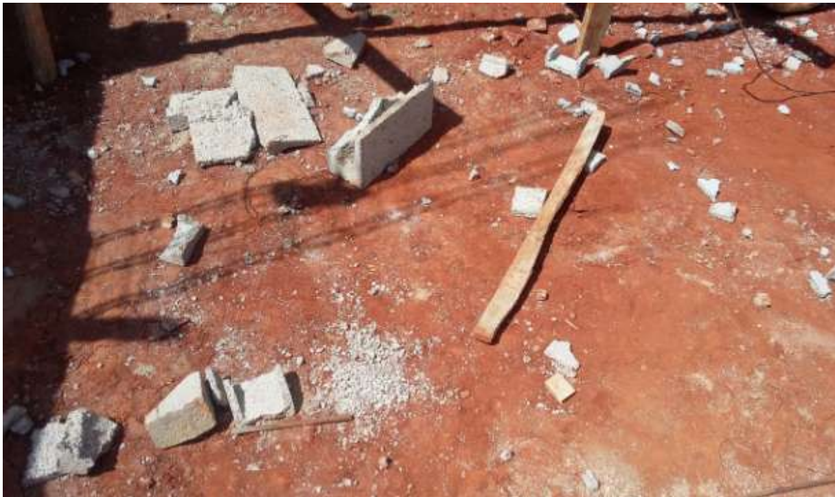
Figura 6- Perdas geradas por cortes com ferramentas não apropriadas
