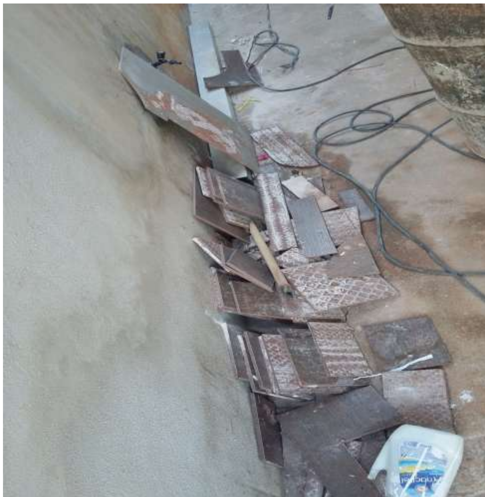
Figura 9 - Recortes de pisos cerâmicos
