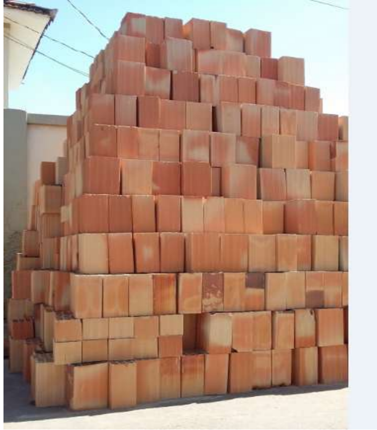
Figura 7- Armazenamento inadequado acima de 2 metros
