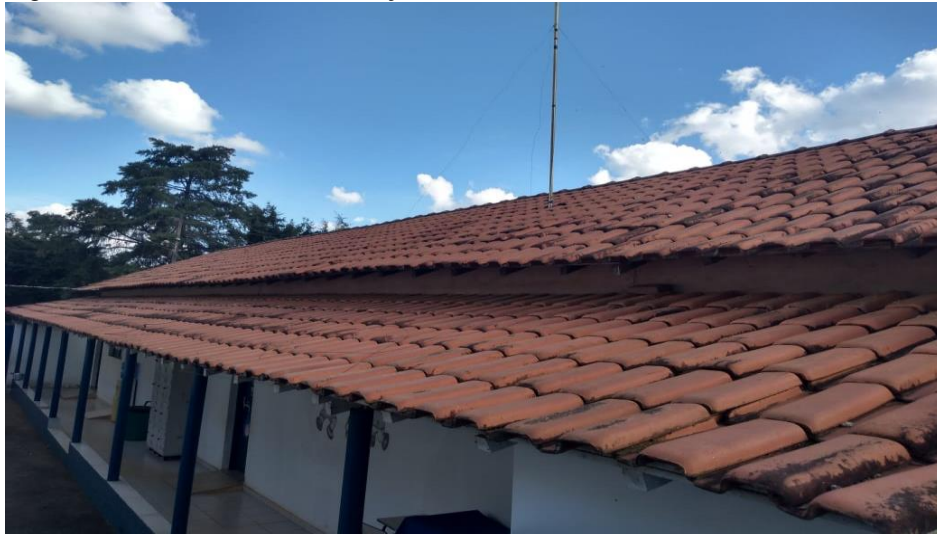
Figura 7– Telhas Cerâmicas edificação 2.
