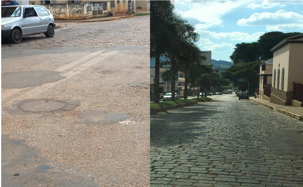
Figura 34 - Pavimentos do Trecho 6 e do Trecho 7.
