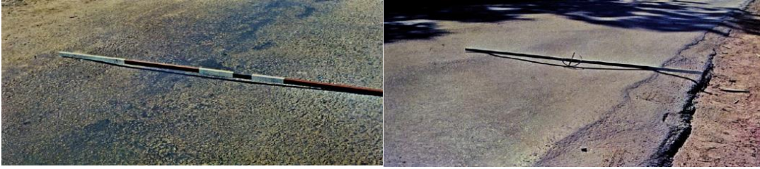
Figura 12 - Afundamento plástico local (ALP) e na trilha da roda (ATP).
