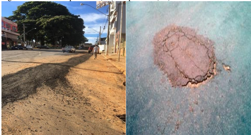
Figura 18 - Remendo profundo (RP) e superficial (RS).
