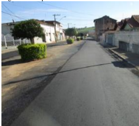
Figura 9 - Recapeamento de uma via.
