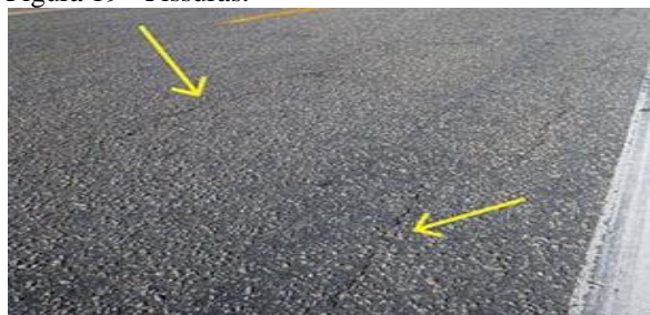
Figura 19 - Fissuras.
