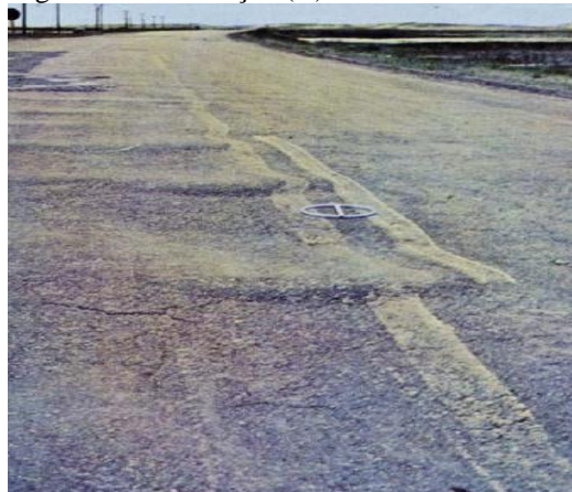
Figura 11 - Ondulação (O).
