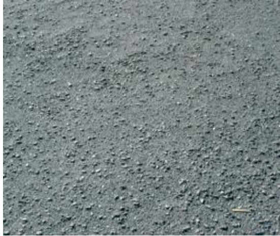
Figura 16 - Desgaste (D).
