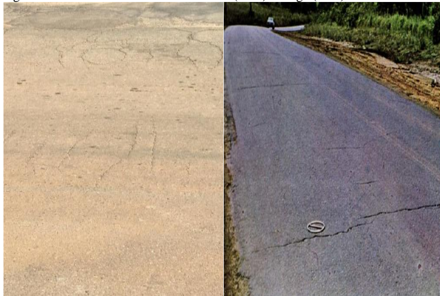
Figura 20 - Trinca isolada transversal curta (TTC) e longa (TTL).
