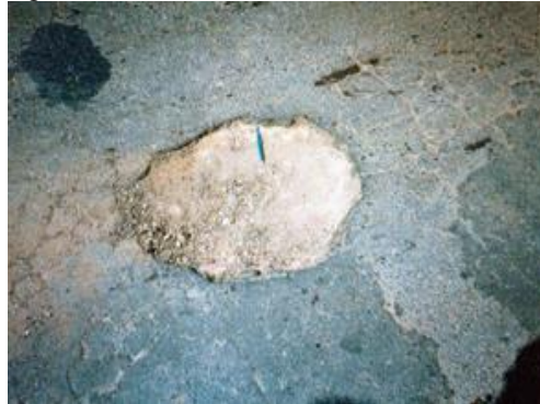
Figura 17 - Panela ou Buraco (P).
