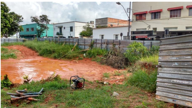
Figura 31 - Área do loteamento tomado por vegetação e sujeira.
