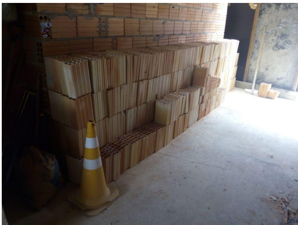
Figura 5 : Local de estoque temporário de blocos cerâmicos na obra B.
