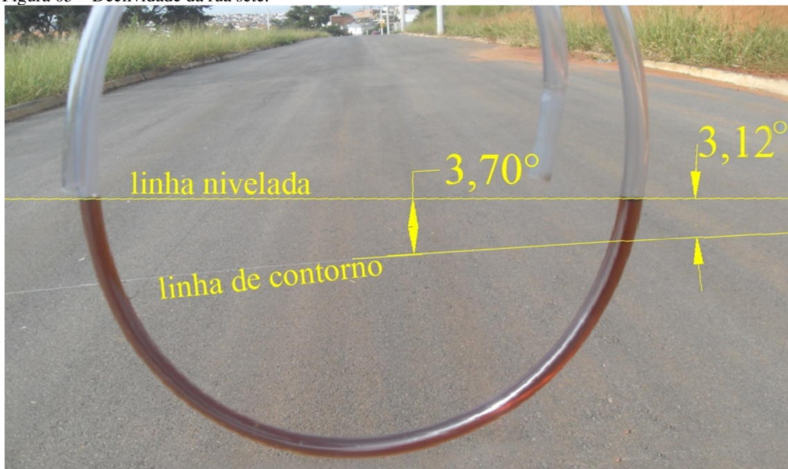
Figura 05 – Declividade da rua sete.
