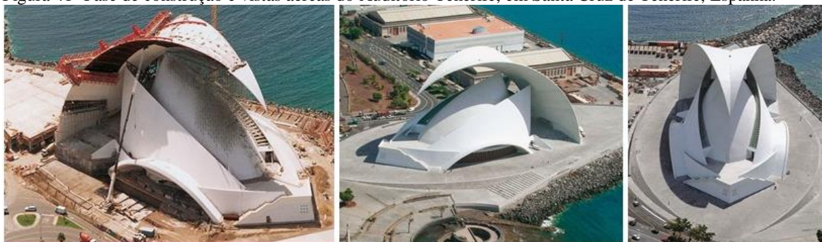
Figura 41 -Fase de construção e vistas aéreas do Auditório Tenerife, em Santa Cruz de Tenerife, Espanha.
