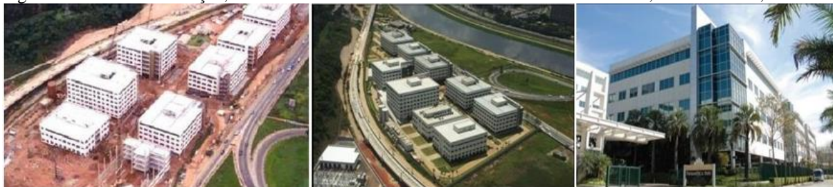
Figura 7 – Fase de construção, Vista Aérea e Fachada do Condomínio Panamerica Park, em São Paulo, SP.
