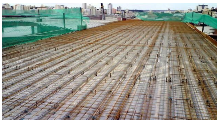
Figura 29 - Detalhe das armaduras em uma laje mista
