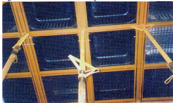
Figura 41 - Escoramento da laje nervurada
