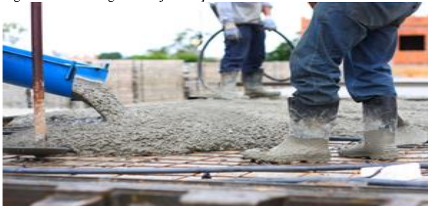
Figura 3 - Concretagem da laje maciça
