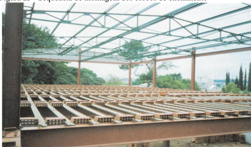
Figura 23 - Sequência de montagem dos blocos de enchimento
