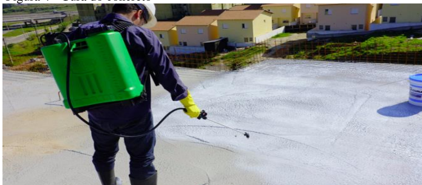
Figura 4 - Cura do concreto
