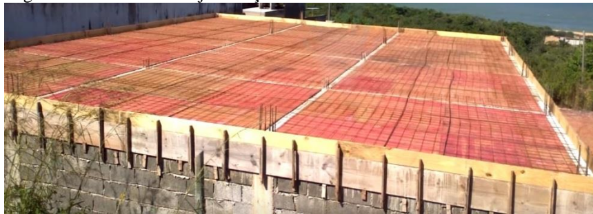
Figura 1 - Escoramento laje maciça
