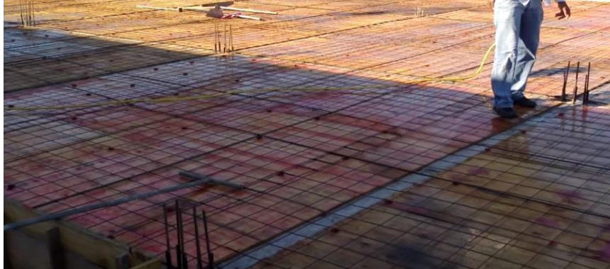
Figura 2 – Umidificação antes da concretagem
