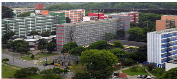
Figura 5 - Conjunto Residencial da Universidade de São Paulo
