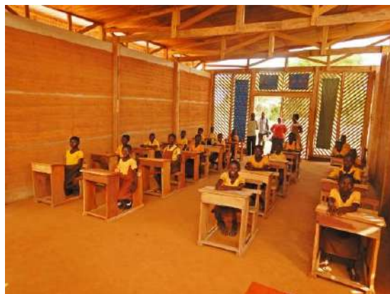
(b) Área interna da sala de aula com tecidos que ajudam a barrar a ventilação direta.
