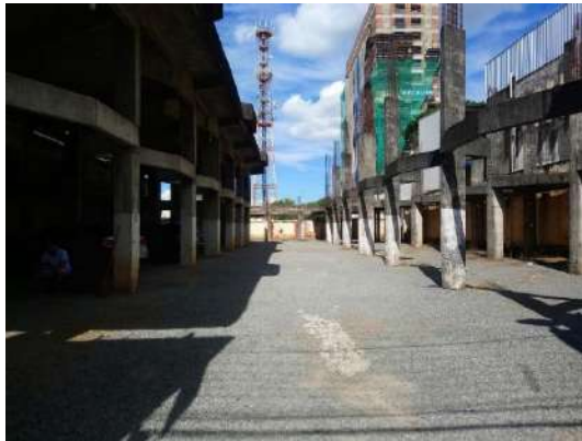
(a) Estrutura antiga na fachada da Praça Getúlio Vargas
