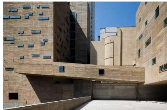
(d) Circulação edifício
