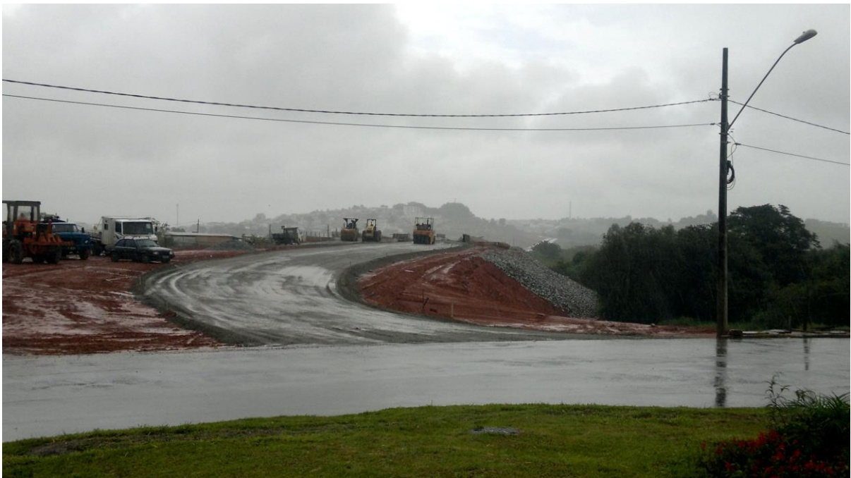
Figura 3 – Avenida Dique II em obras de pavimentação.
