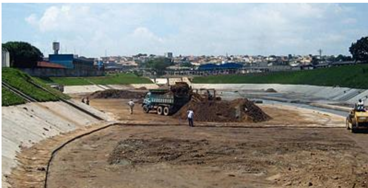
Figura 11 – Limpeza do Piscinão da Vila Pauliceia em São Bernardo – SP.
