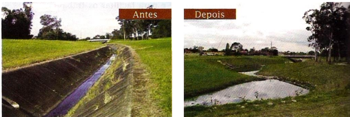
Figura 2 – Exemplo de restauração das condições naturais de um córrego em Sidney, Austrália.
