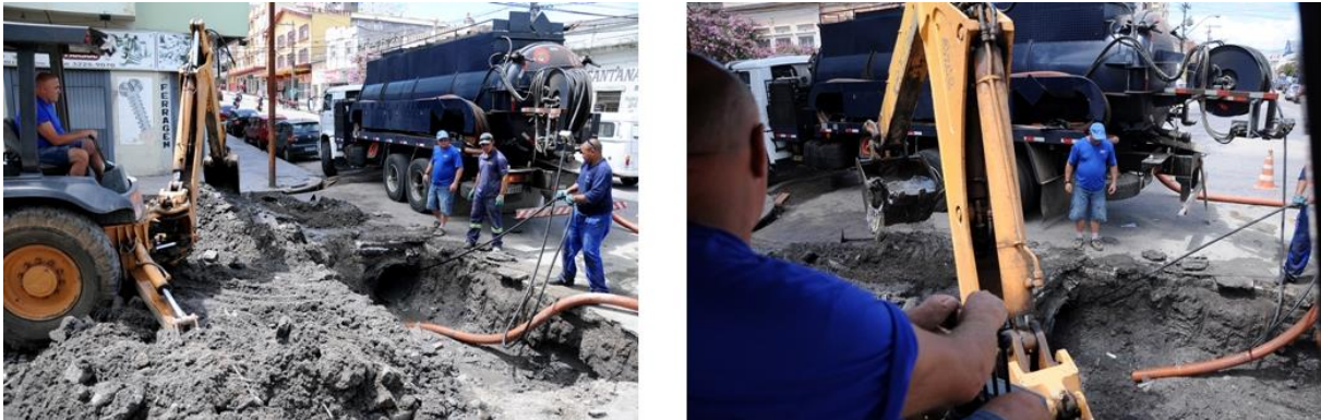
Figura 10 – Desobstrução de Tubulação no Centro de Pelotas – RS.
