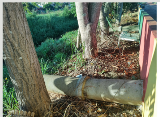
Figura 33: Nova tubulação da Ponte do Ribeirão. Fontes: A autora, 2023.
