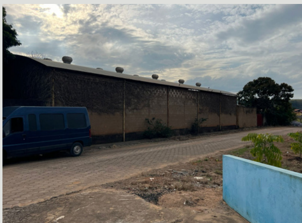
Figura 17: Galpão: Centro de Eventos.
