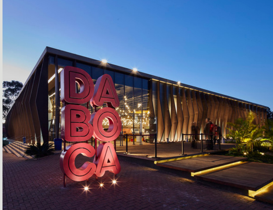
Figura 40: Fachada Mercado da Boca.
