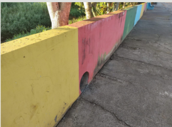
Figura 32: Saída de água da ponte do Ribeirão. Fontes: A autora, 2023.
