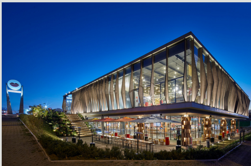
Figura 41: Fachada Mercado da Boca.
