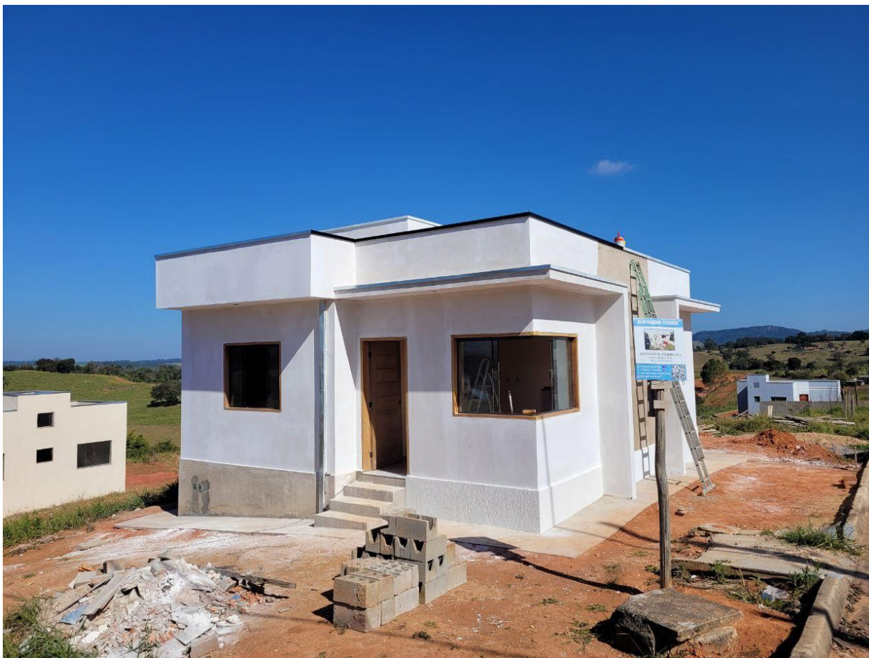
Figura 12 - Pintura Externa da Casa
