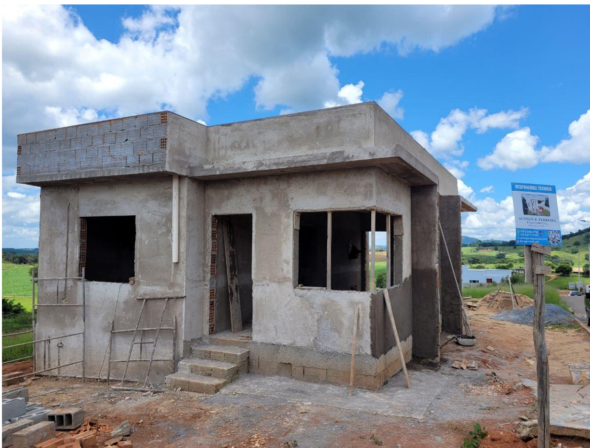
Figura 11 - Laje e calha finalizada
