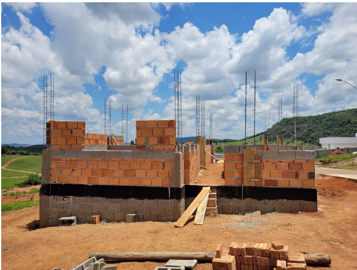
Figura 9 - Supraestrutura e Início dos Pilares
