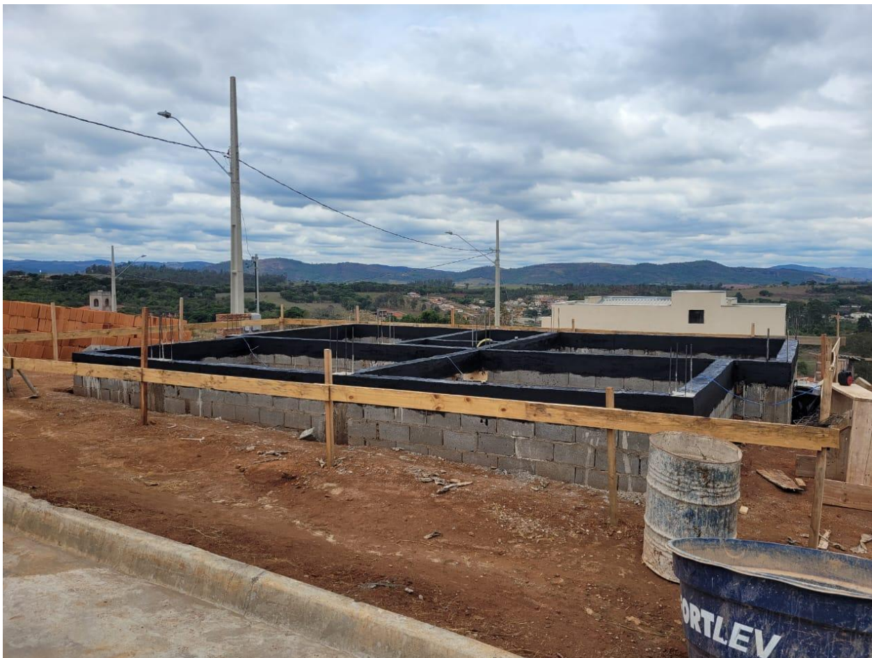
Figura 8 - Execução da Infraestrutura do Imóvel
