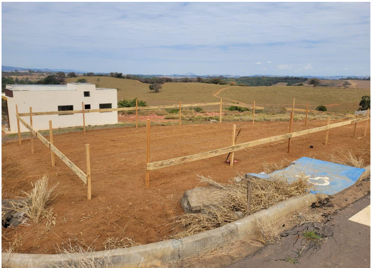
Figura 7 - Terreno Limpo e Gabarito Demarcado para Início da Obra
