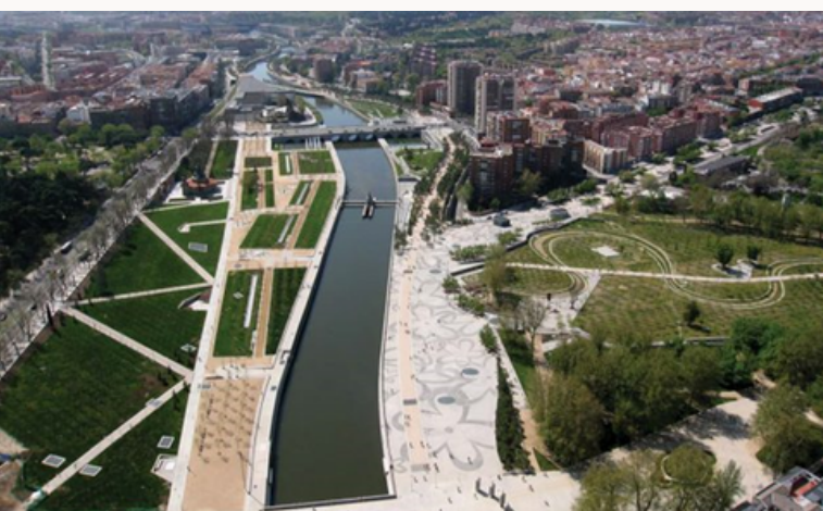
Figura 9: Parque Linear com a presença de um rio em Madrid
