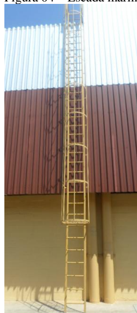
Figura 04 – Escada marinheiro externa para acesso vertical
