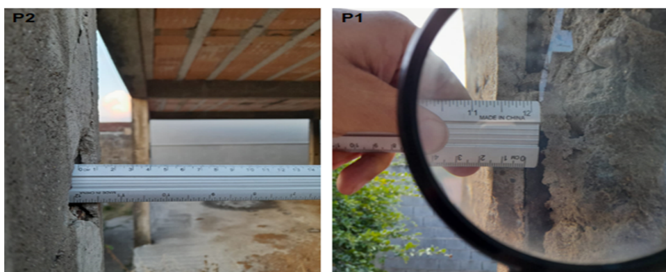
Figura 4: Medição da espessura da camada de cobrimento dos pilares, P1 e P2.
