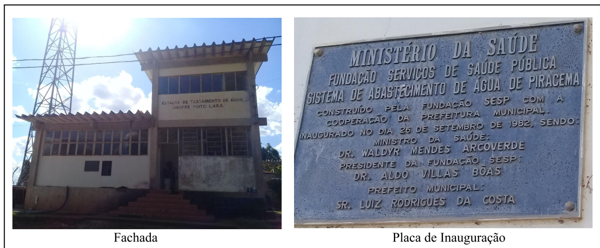
Figura 4. Estação de Tratamento de Água “Onofre Pinto Lara”
