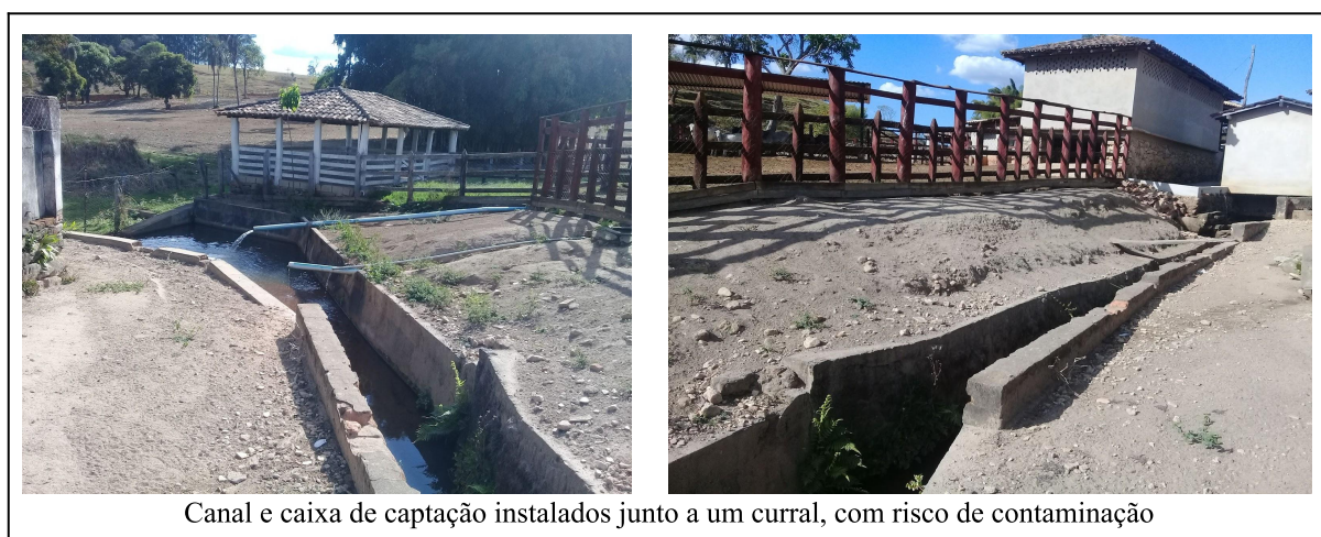
Figura 9. Captação do Córrego da Laje
