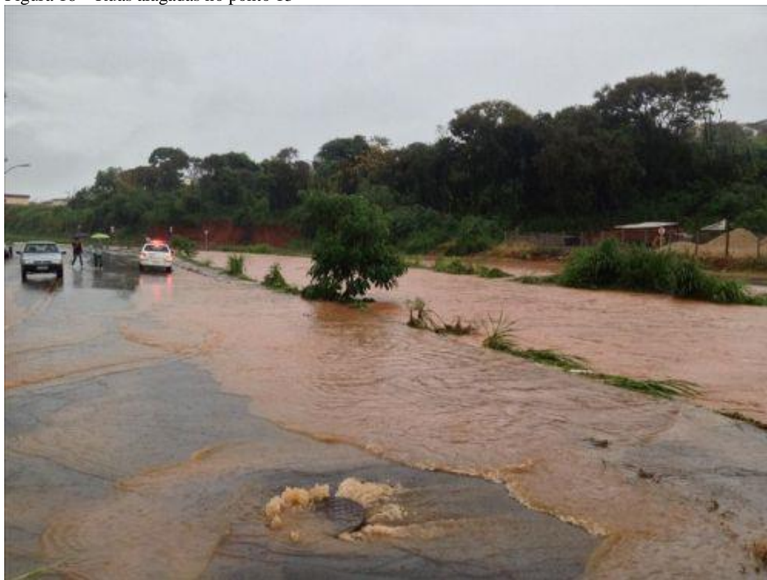
Figura 18 – Ruas alagadas no ponto 13
