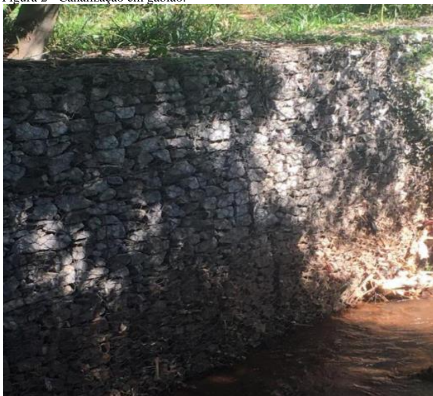
Figura 2 - Canalização em gabião.
