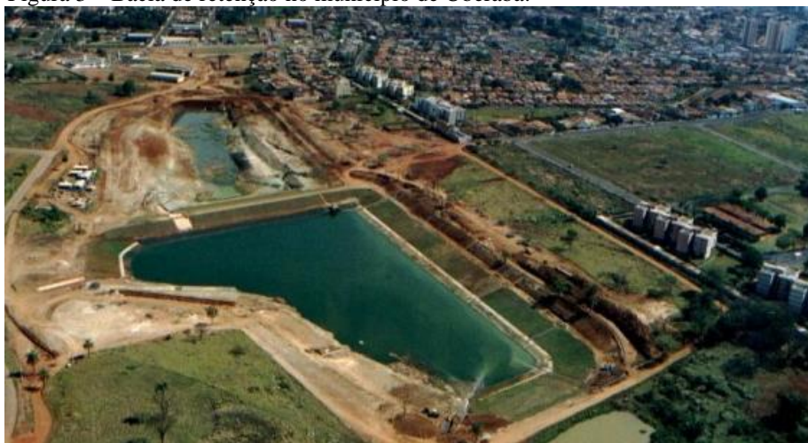
Figura 3 – Bacia de retenção no município de Uberaba.
