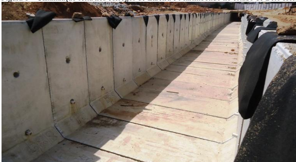
Figura 1 – Canalização feita nos córregos de Lareira e Marimbondo no estado de Belo Horizonte.
