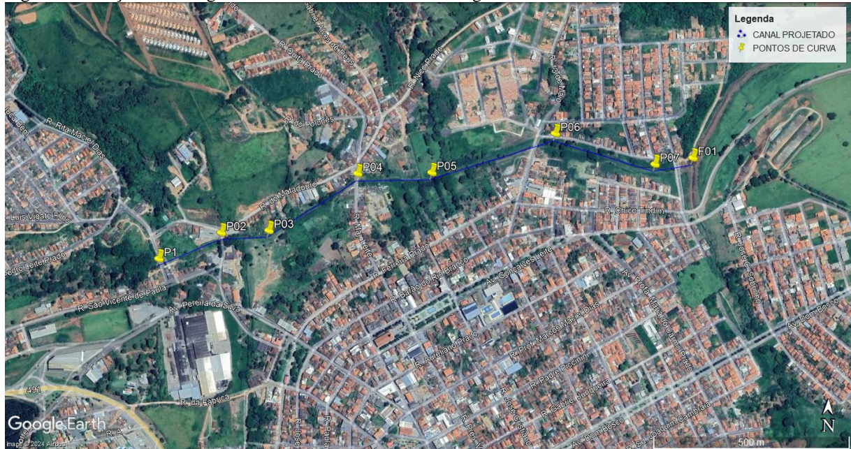
Figura 11 – Seção do córrego com risco de deslizamento e Alagamento
