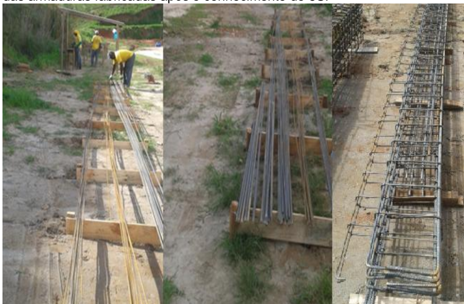
Figura 29 - Central de armaduras, Apoio para as barras de aço, Armazenagem das armaduras fabricadas após o conhecimento do 5S.
