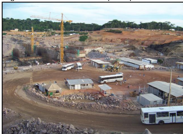
Figura 2 - Canteiro de obras tipo amplo
