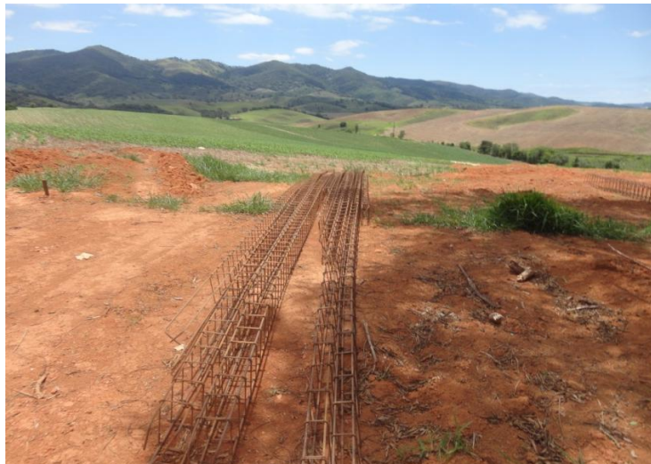
Figura 20 - Armaduras fabricadas em contato direto com o chão
