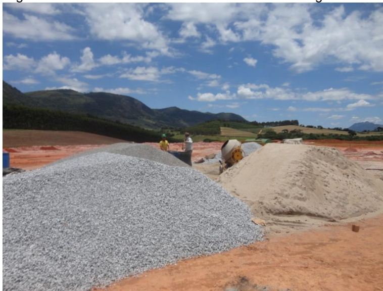
Figura 21 - Local onde é fabricado o concreto e a argamassa
