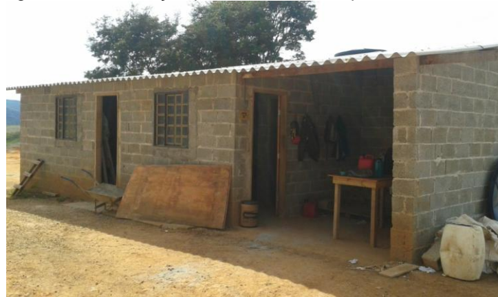
Figura 14 - Construção provisória utilizada para diversas
