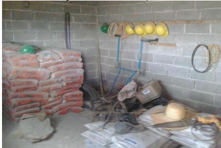
Figura 17 - Sacos de cal e sacos de cimento refratário armazenados sem proteção contra umidade ascendente, equipamentos e ferramentas desorganizados e falta de limpeza no local
