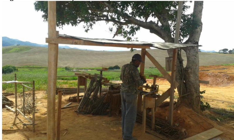
Figura 18 - Local improvisado para dobras de estribos e outros
