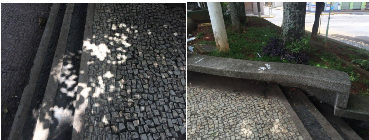
Figura 48: Piso de Pedra Portuguesa e bancos de concreto revestidos de granilite na Praça do ET. Fonte: A autora
