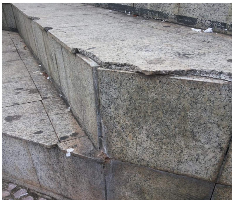
Figura 49: Arquibancada com revestimento de granito na Praça do ET. Fonte: A autora
