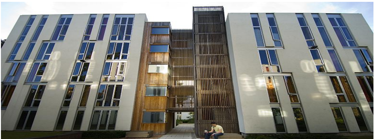
Figura 5 – Foto externa da moradia estudantil Alliance Student Housing Arquitetos: Haworth Tompkins Architects (2017, p.1)
