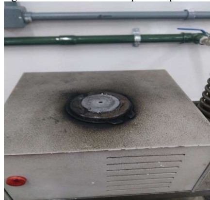
Figura 34: Fechamento da parte superior
