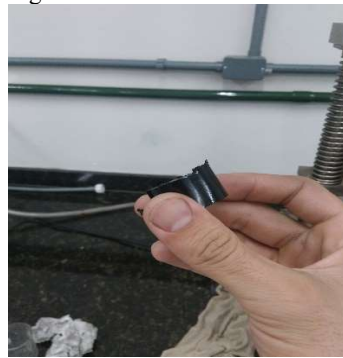
Figura 43: Rebarba na extremidade
