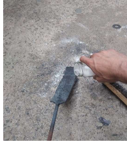
Figura 19: Banho de ácido bórico
