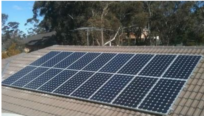
Figura 95: Pannel fotovoltaico 24 V de sistema autônomo
