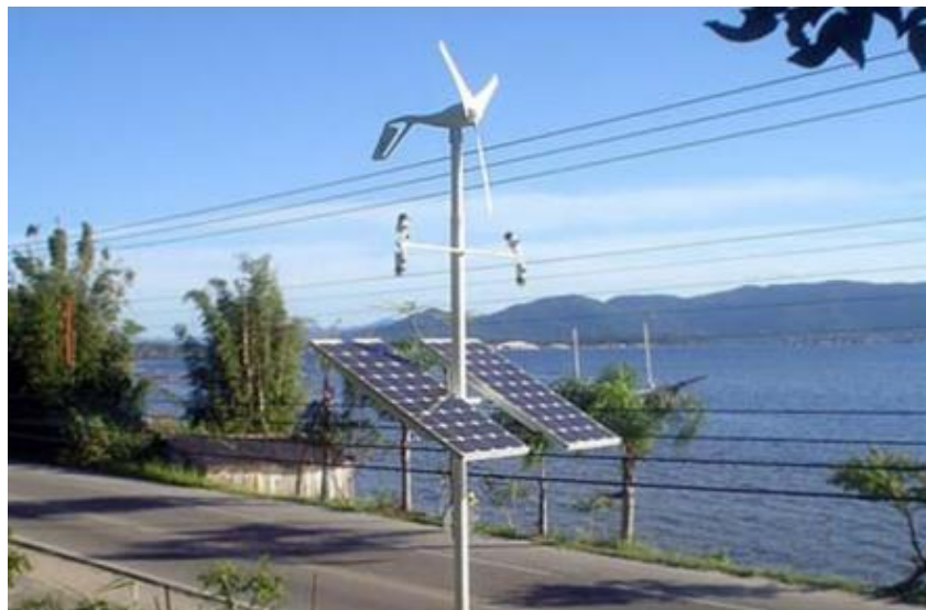
Figura 18: Sistema híbrido eólico fotovoltaico
