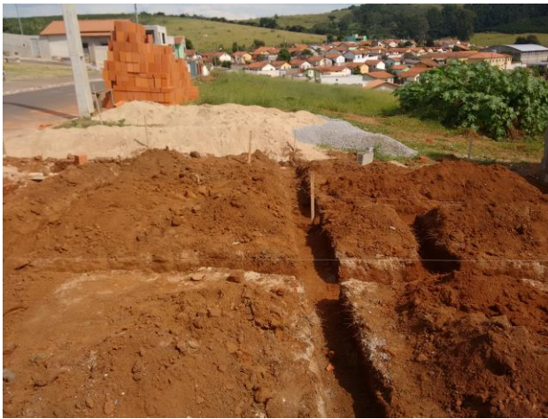
Figura 2 – Armazenagem de materiais.
