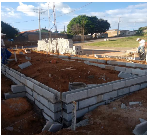
Figura 4 – Levantamento de bloco.
