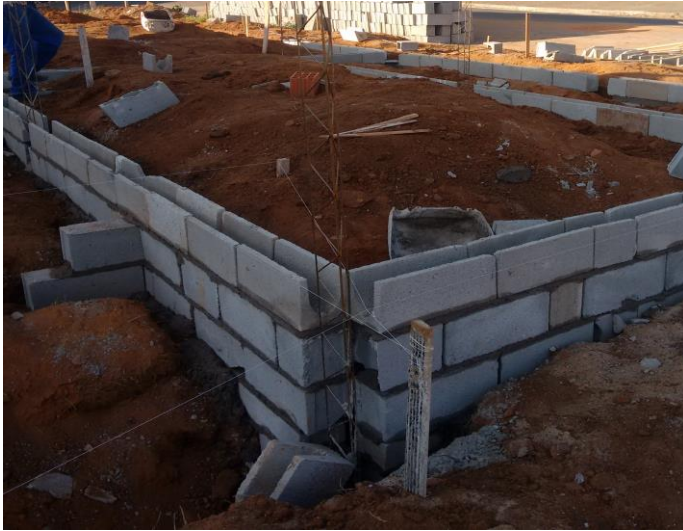
Figura 7 – Proteção das ferragens.
