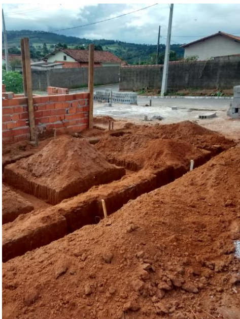
Figura 1 – Canteiro de obra.
