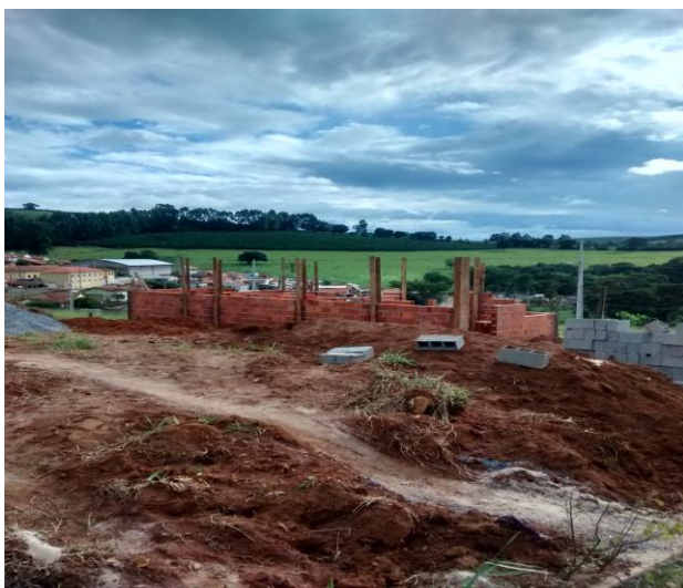
Figura 3 –Destinação de demolição.
