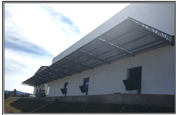
Figura 04 - Foto do final da obra
