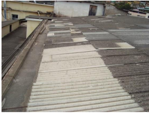
Figura 9 – Telhado antigo antes da reforma Fonte: da pesquisa, 2018.
