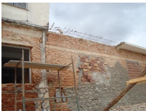
Figura 3 – Andaime improvisado na demolição da Fachada Lateral em reforma 2
