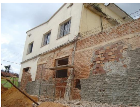
Figura 2– Fachada lateral em reforma 1
