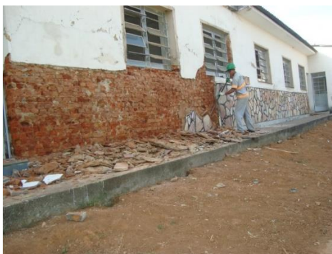
Figura 8– Remoção de pedra são Tomé na fachada Fonte: da pesquisa, 2018.
