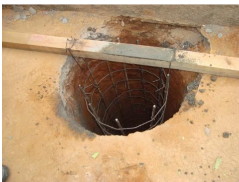
Figura 7 – Armação para tubulação, pronto para concretar Fonte: da pesquisa, 2018.
