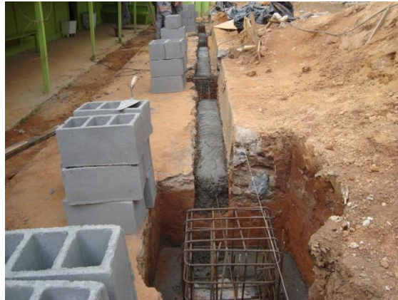
Figura 5 - Cinta de bloco de fundação
