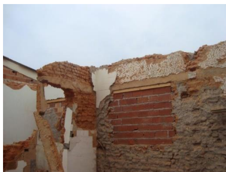
Figura 1 – Demolição de Alvenaria 1 Fonte: da pesquisa, 2018.
