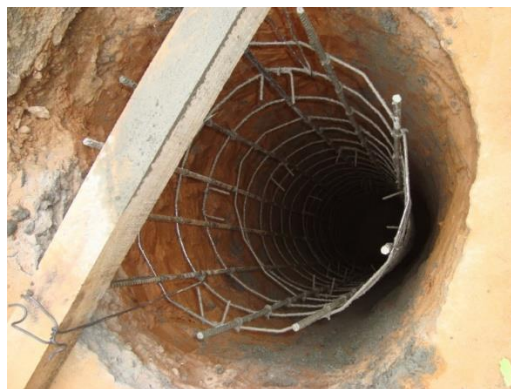
Figura 6– Armação para tubulação
