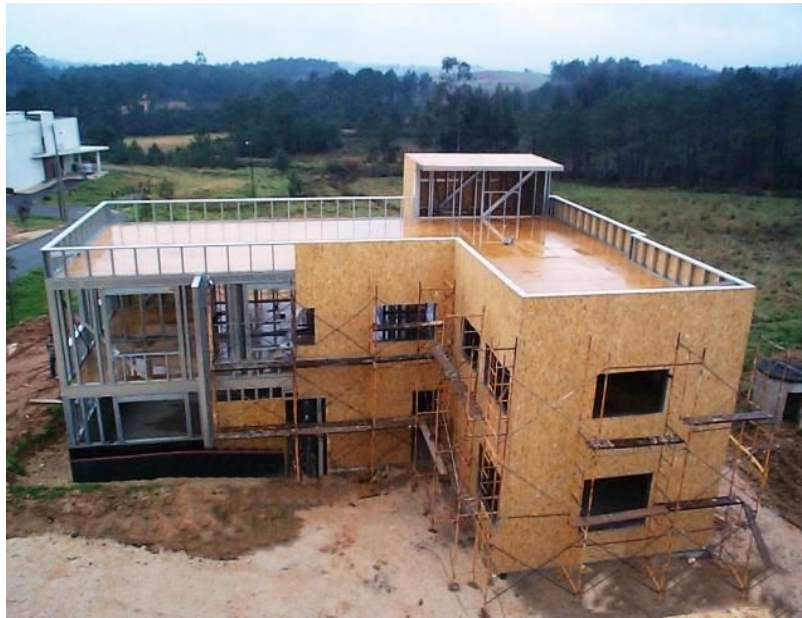
Figura 8: Telhado plano em LSF
