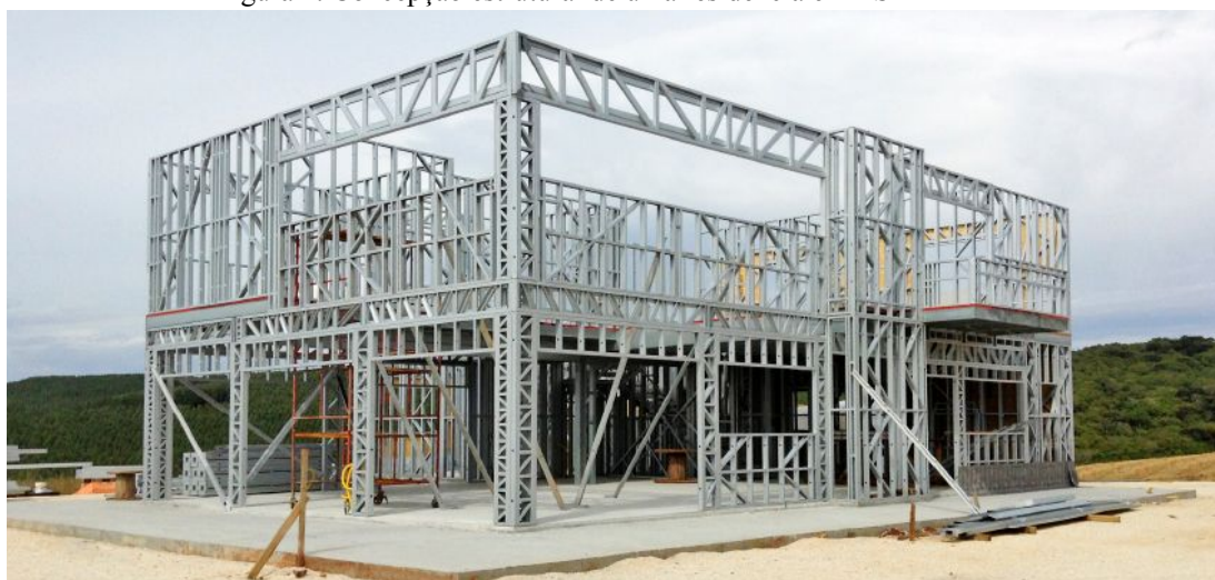
Figura 1: Concepção estrutural de uma residência em LSF
