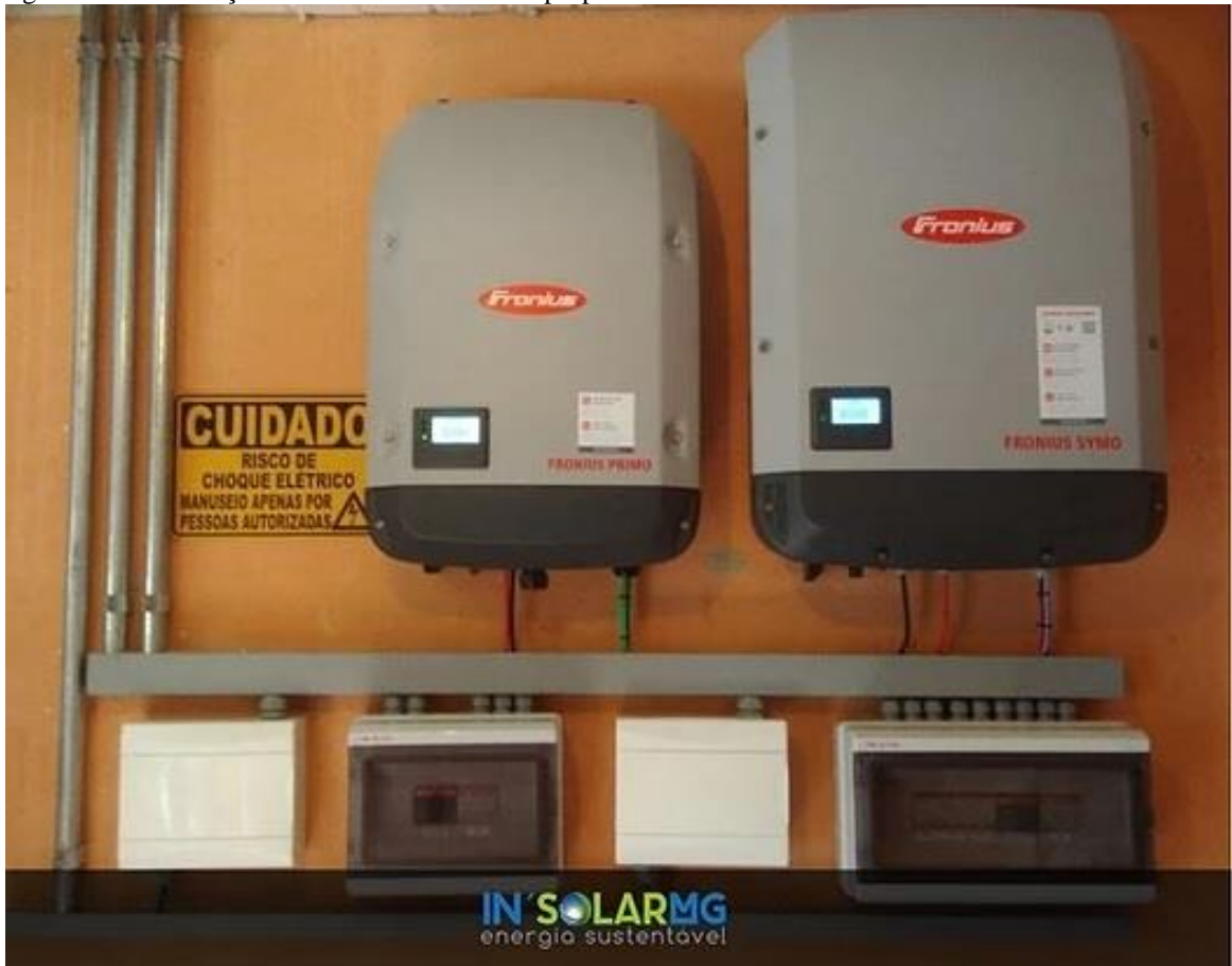
Figura 106 – Instalação de inversores conforme proposto.
