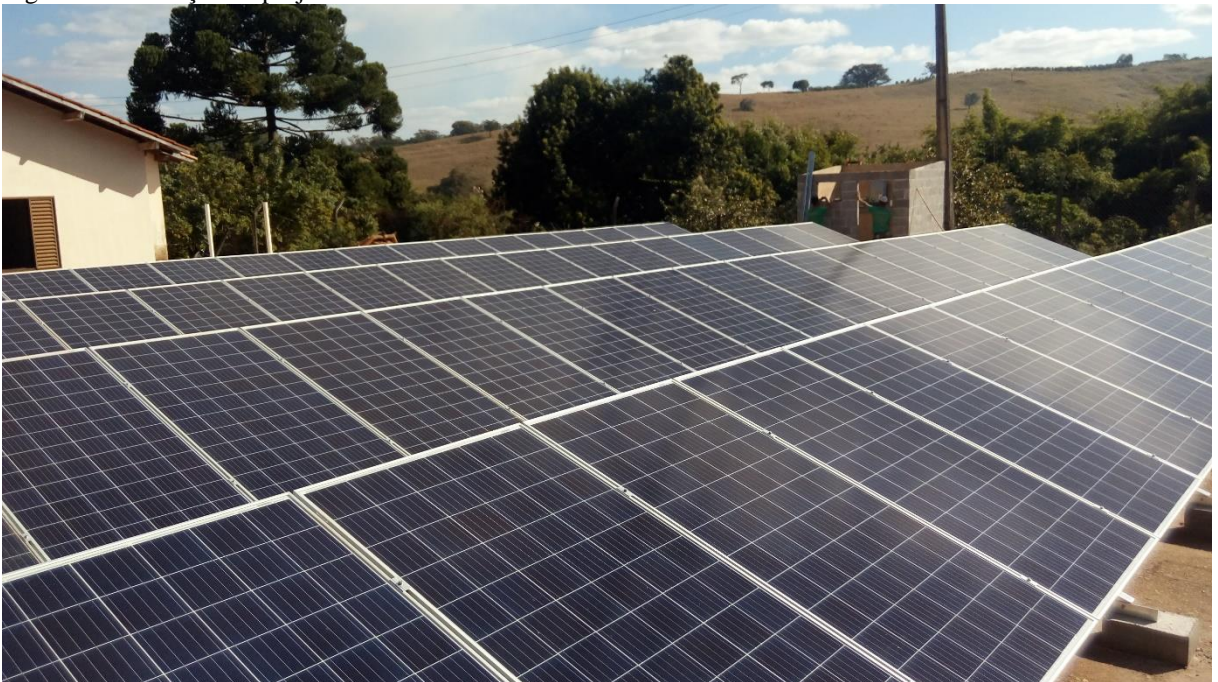
Figura 36: Execução de projeto – detalhe.
