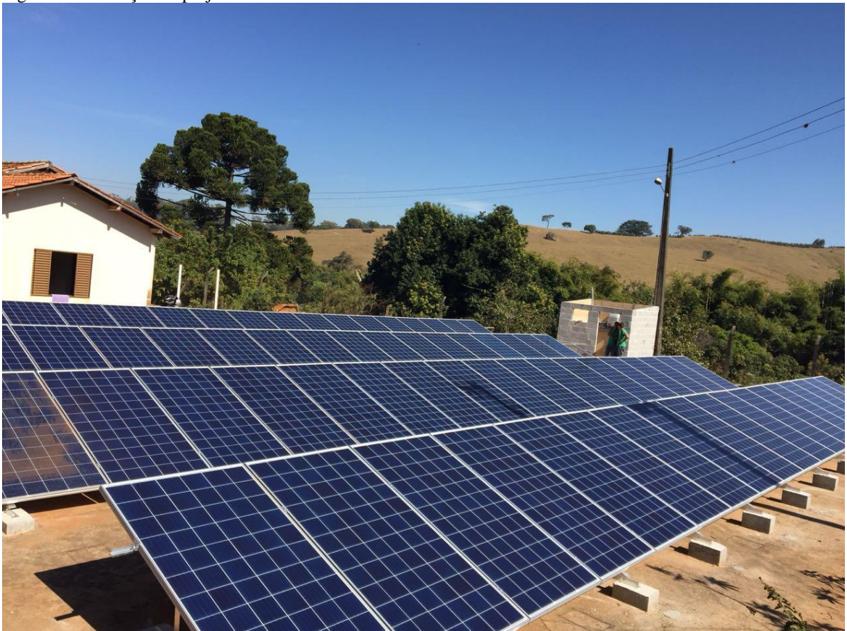
Figura 34: Execução de projeto - vista frontal
