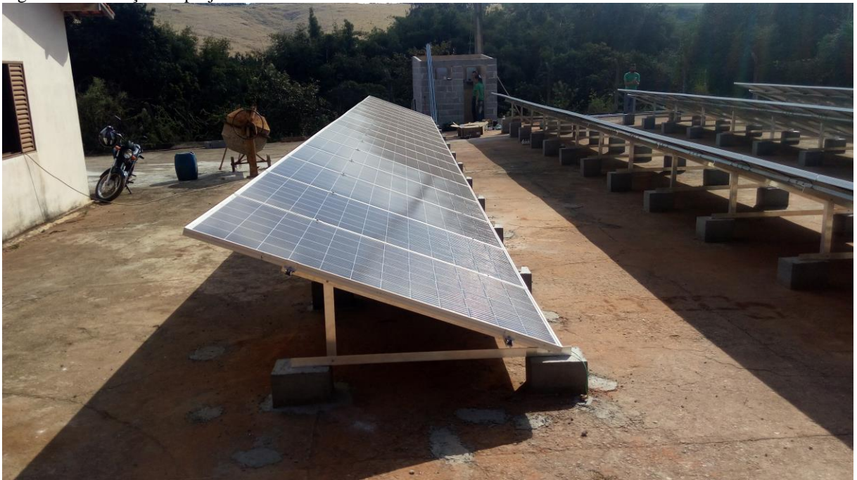
Figura 38: Execução de projeto – vista lateral.
