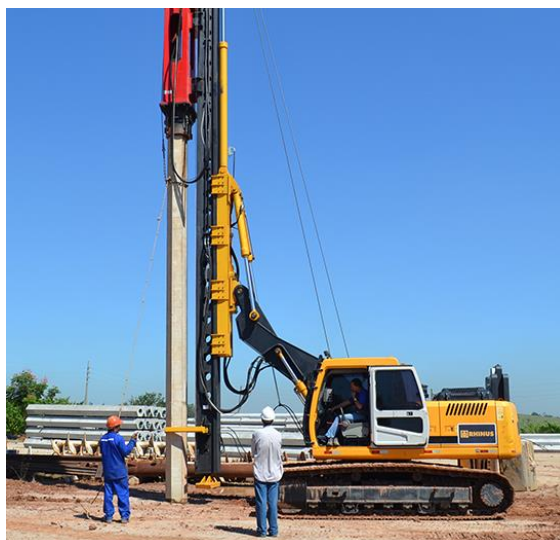
Figura 04 - Bate estaca hidráulico
