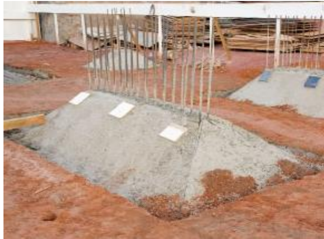
Figura 01 - Fundação rasa em sapata
