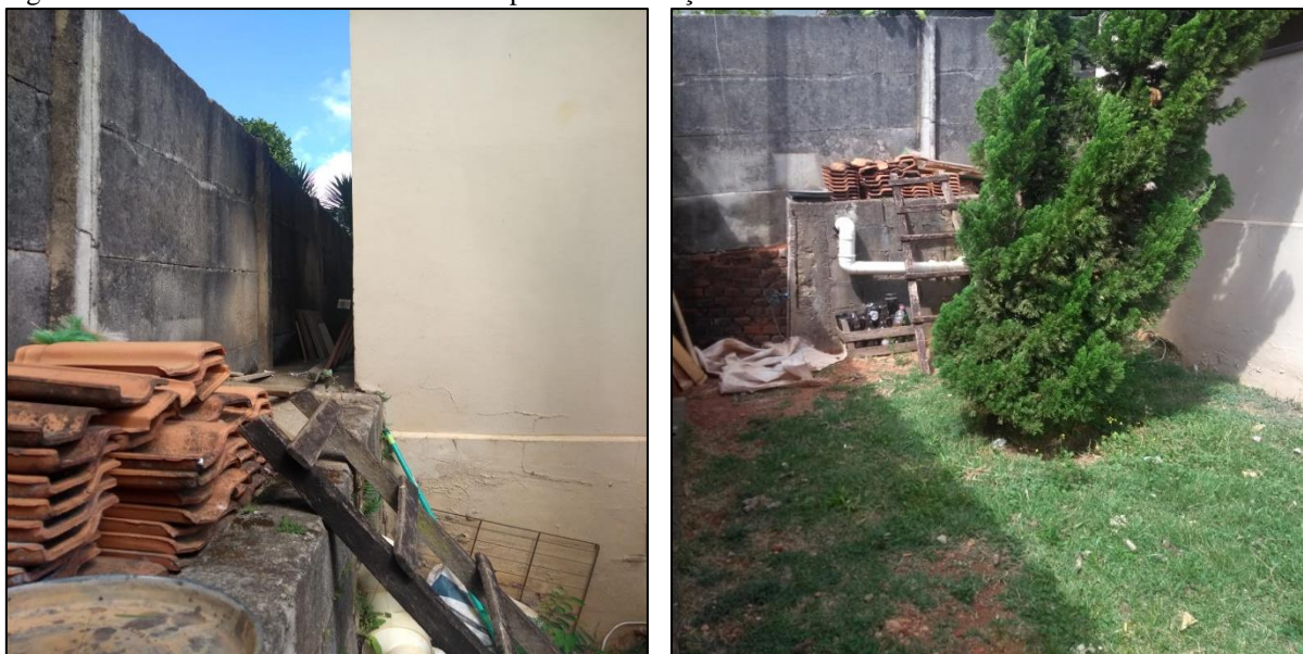
Figura 9: Bancada em contato direto com a parede de vedação
