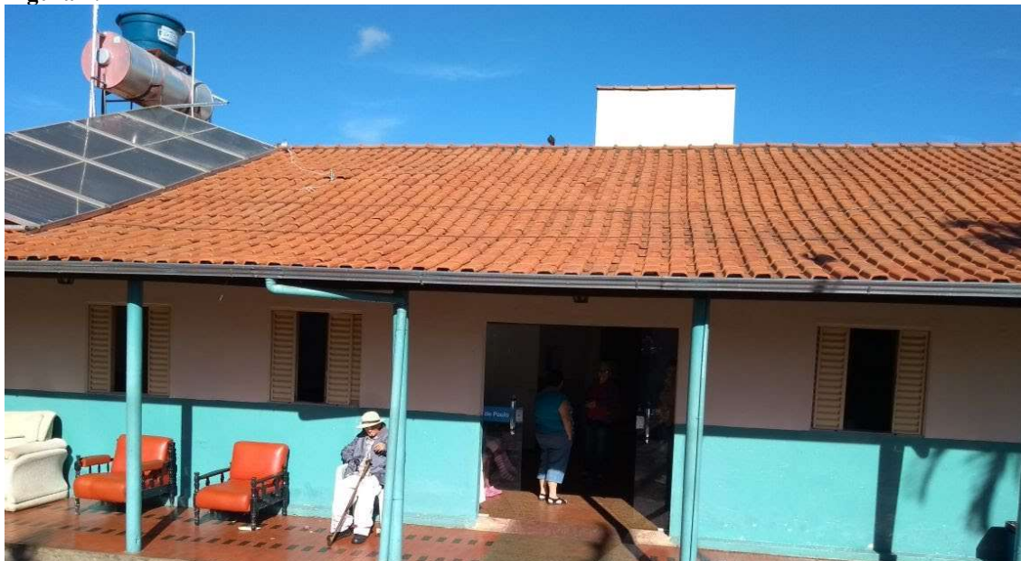
Figura 2: Telhado do Lar São Vicente de Paulo de Carmo da Cachoeira.
