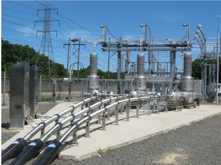
Figura 1 - Linha de transmissão utilizando supercondutores em Long Island , EUA.
