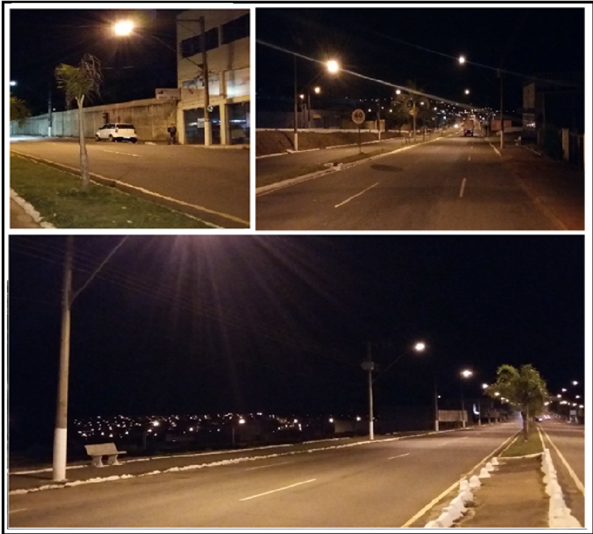
Figura 26 – Fotos da Avenida Deputado Renato Azeredo com luminária VSAP
