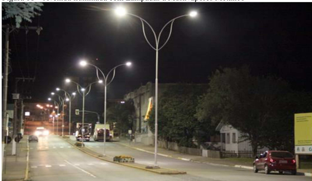
Figura 18 – Avenida iluminada com Lâmpadas a Multivapores Metálico
