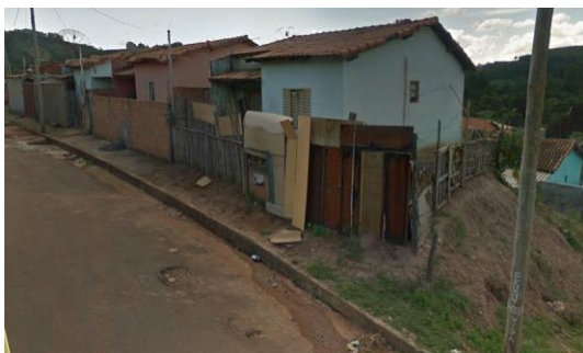
Figura 44– Improviso no fechamento
