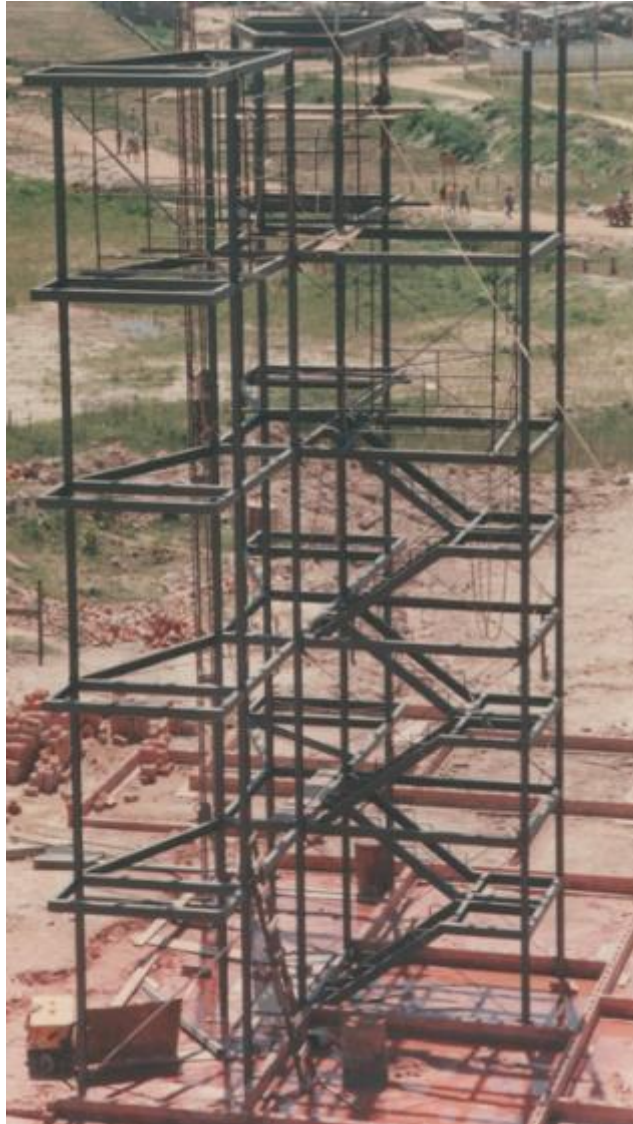
Figura 25 - Escadaria em estrutura metálica independente
