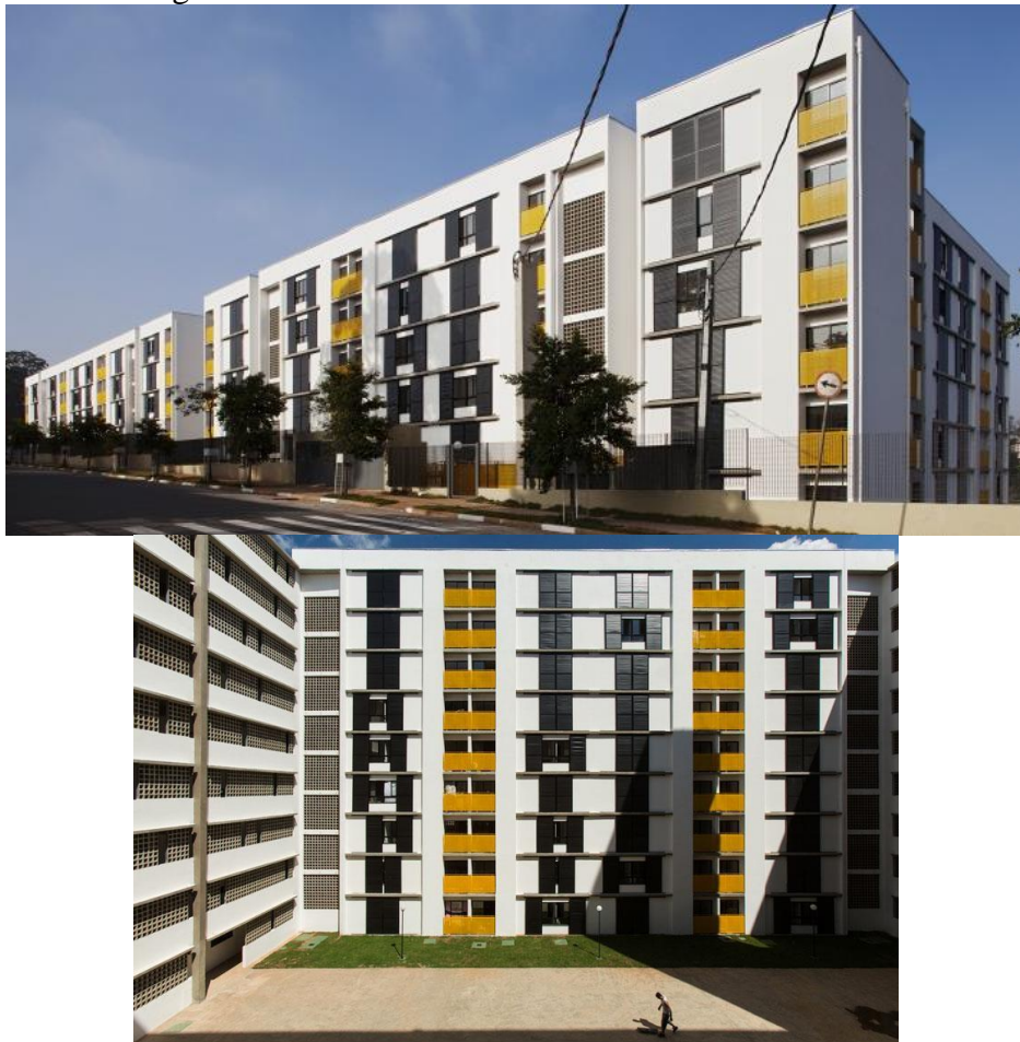
Figura 18 - Vistas externa e interna do Residencial Corruíras
