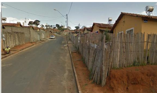
Figura 45– Falta de Acessibilidade
