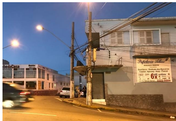
Figura 76: Fiação exposta na Av. Major Venâncio. Fonte: Arquivos Pessoais, 2018
