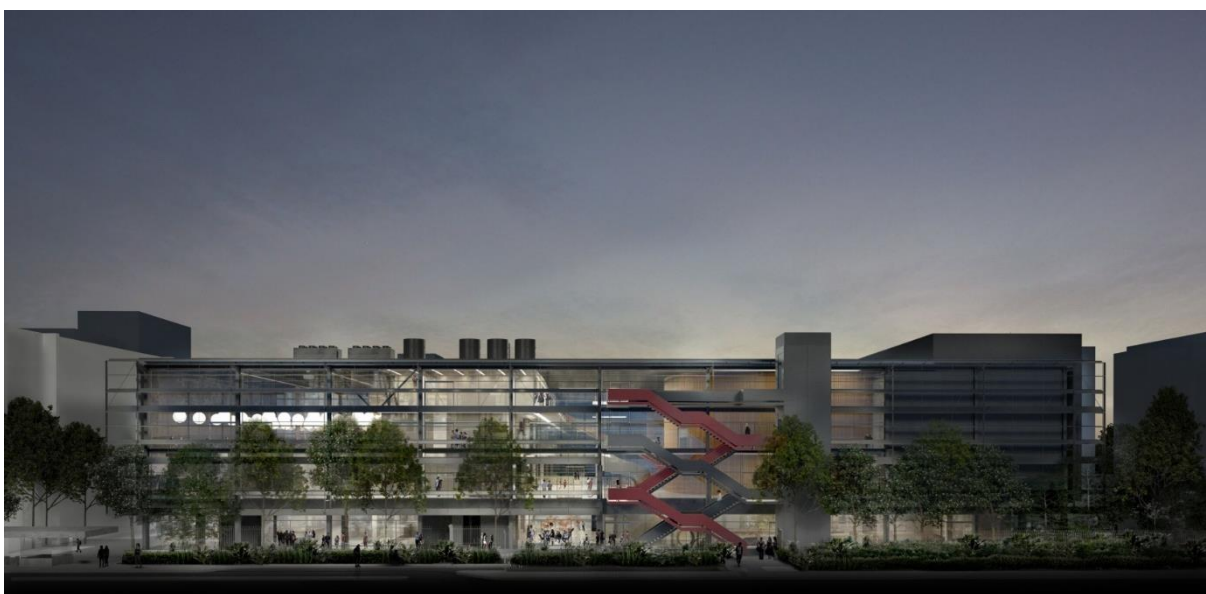
Figura 34: Fachada voltada para a Rua Tucumã
