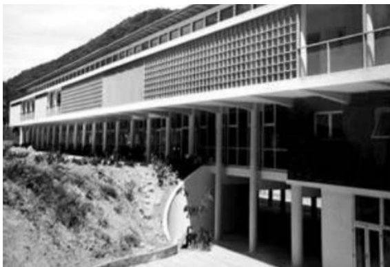
Figura 19: Fachada sul da Colônia de Férias do IRB e a composição de diferentes materiais.
