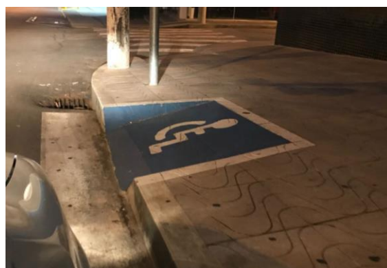
Figura 81: Rampa de acesso localizada na Avenida Benjamin Constant.
