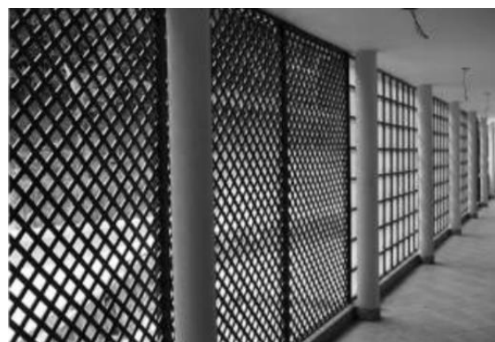
Figura 24: Detalhe da circulação dos dormitórios.
