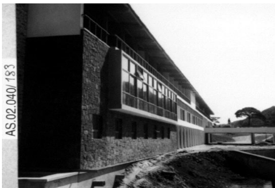
Figura 21: Fachada norte da Colônia de Férias do IRB e o uso de pedras naturais.
