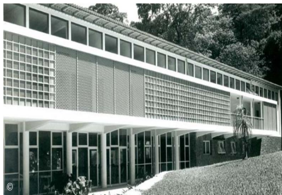
Figura 20: Composição da fachada sul em vidro, concreto, treliças e venezianas de madeira.
