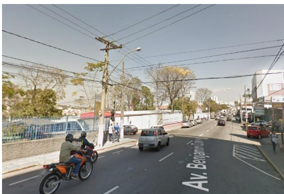
Figura 75: Fiação exposta na Av. Benjamin Constant. Fonte: Google Earth, 2018
