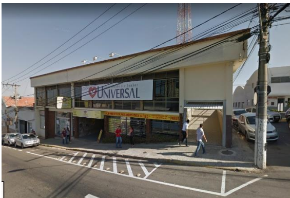
Figura 94: Edificação de uso religioso localizada na Avenida Major Venâncio. Fonte: Google Earth, 2018.
