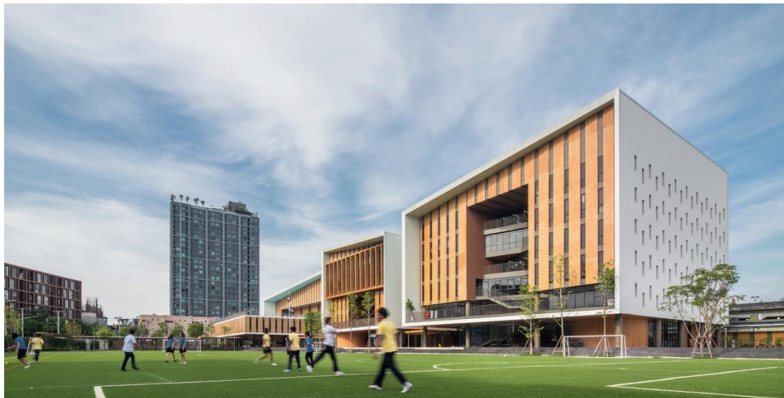
Figura 5 - Edifício da Escola de Bangkok
