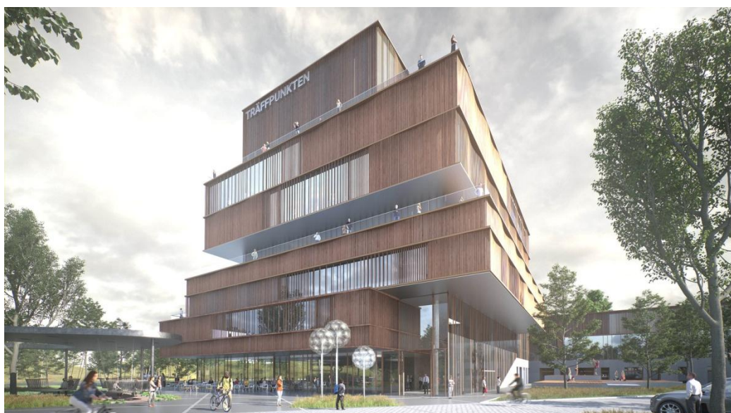
Figura 7 - Fachada principal do Centro de Ciências
