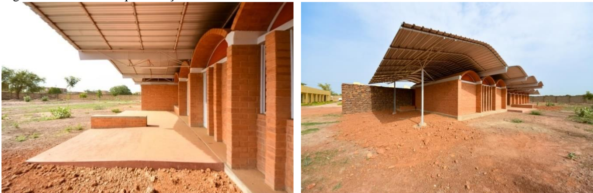
Figura 12 - Cobertura que avança os limites da Casa Kisito
