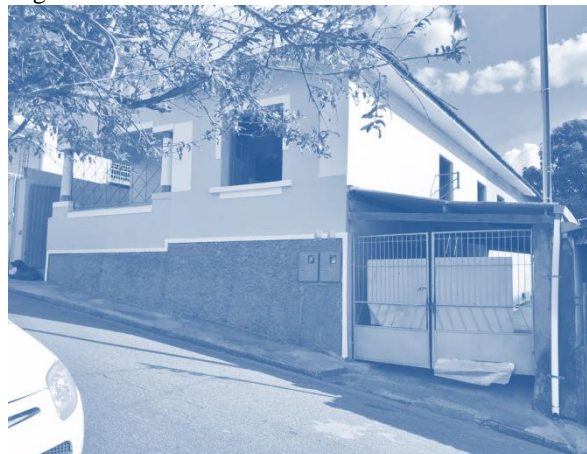
Figura 2 - Fachada norte da residência
