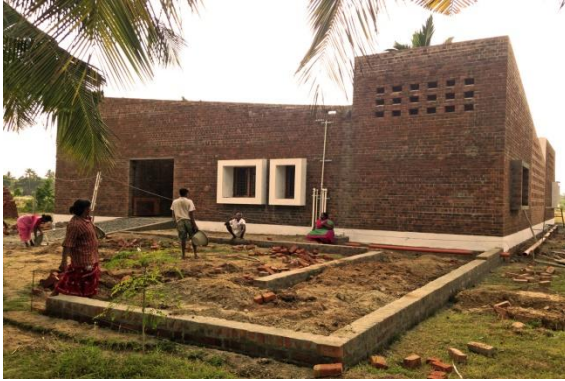
Figura 27 - Fachada posterior da Casa Vellore
