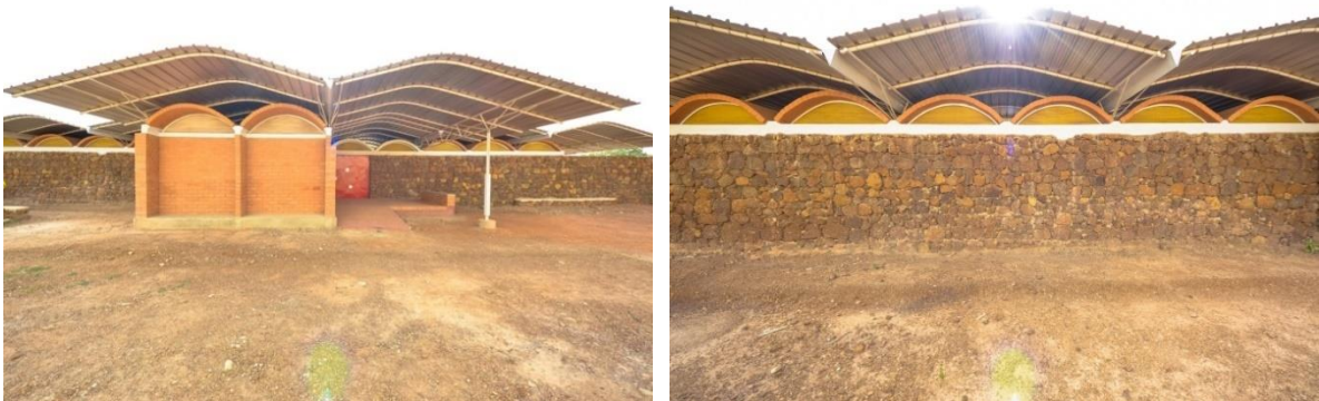
Figura 11 - Muro em pedra da Casa Kisito
