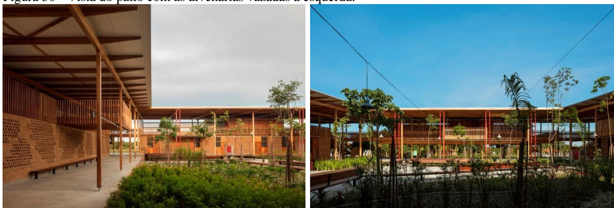
Figura 30 - Vista do pátio com as alvenarias vazadas a esquerda.
