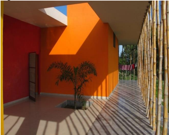
Figura 17 - Efeito de luz e sombra derivado do brise
