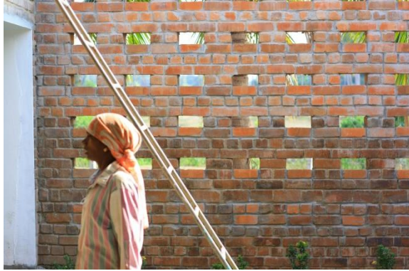
Figura 28 - blocos de Jaali alternados
