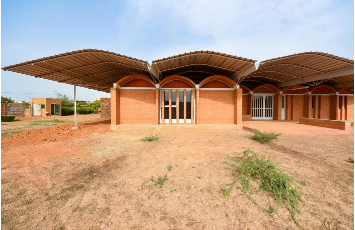
Figura 10 - Vista da Casa Kisito, fachada oeste.
